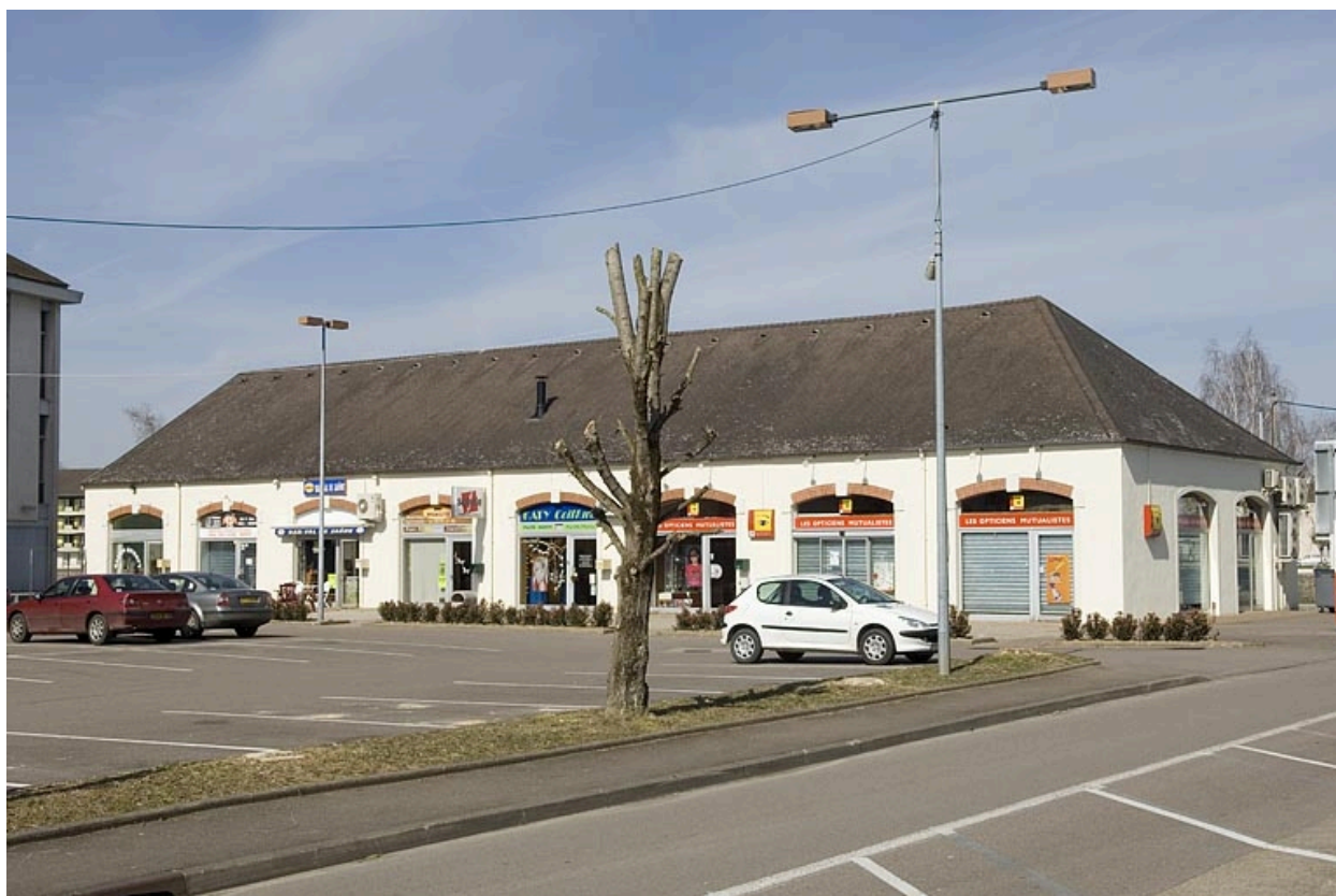
Atelier de fabrication (machines-outils). Façade sud.
