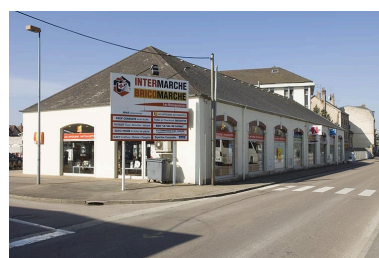
Atelier de fabrication (machines- outils) vu de trois quarts. Phot. Jérôme Mongreville IVR43_20097000180NUC2A
