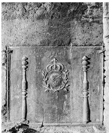
Intérieur : plaque de la cheminée dite "Platine". Phot. Bernard Lardière IVR43_19777000192X
