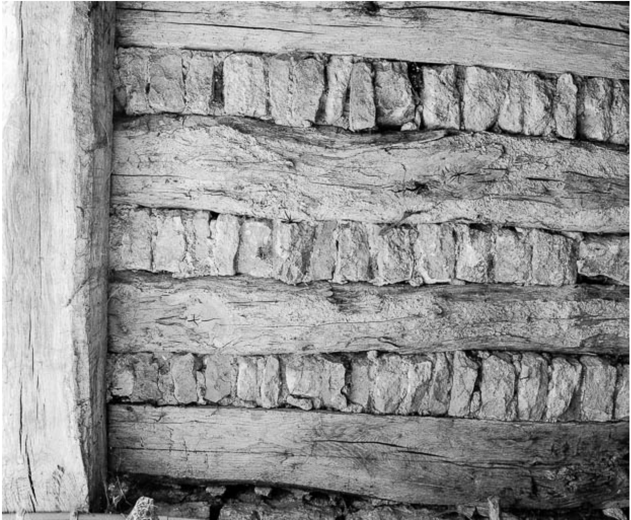
Plafond de la cave : hourdis de pierre.
