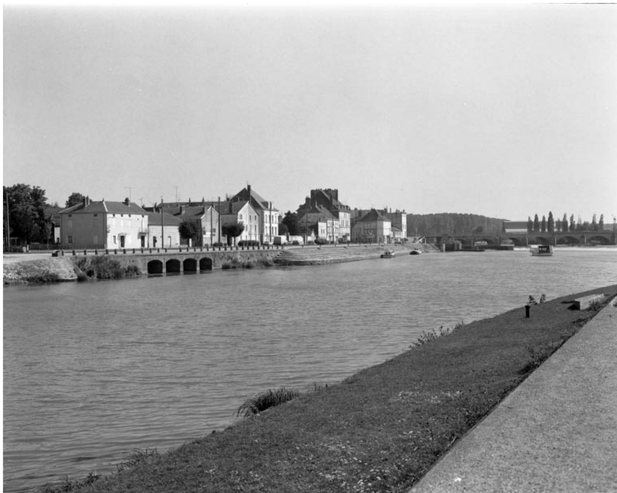
Le quai Villeneuve depuis le quai Mavia : vue éloignée.
