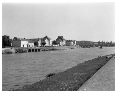
Le quai Villeneuve depuis le quai Mavia : vue éloignée. Phot. Yves Sancey IVR43_19887000053X
