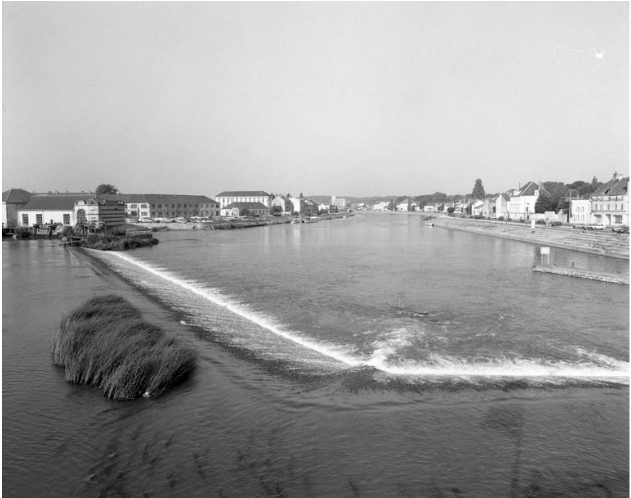
Les quais Mavia et Villeneuve depuis le barrage.
