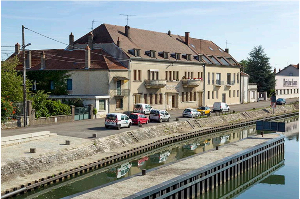
Le quai Vergy et la maison de la navigation, actuelle subdivision de Voies Navigables de France.
