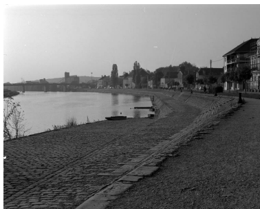
Vue d'ensemble du quai Villeneuve avec les silos en arrière-plan. Phot. Yves Sancey IVR43_19947000043X
