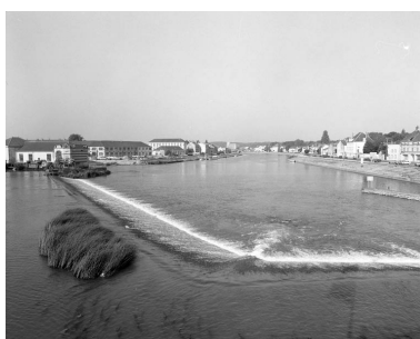
Les quais Mavia et Villeneuve depuis le barrage.
