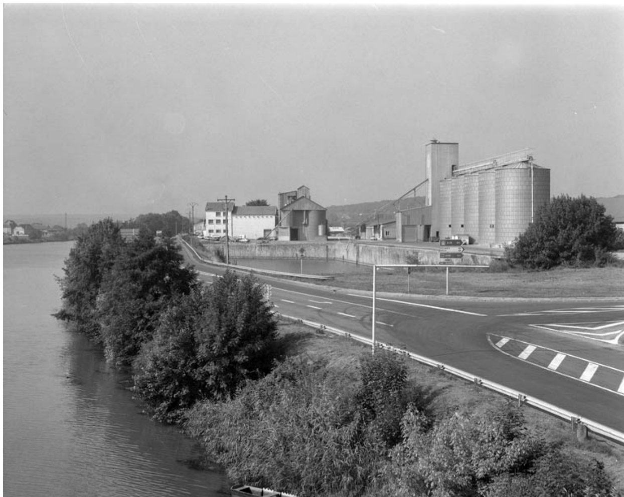
La gare fluviale et les silos : vue éloignée.
