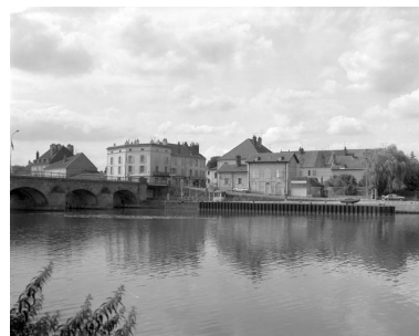
Vue du quai Vergy avec l'écluse et la maison de l'éclusier. Phot. Yves Sancey IVR43_19887000067V
