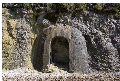
Cinquième abri (à gauche de la voie). Phot. Yves Sancey IVR43_20073900136NUCA
