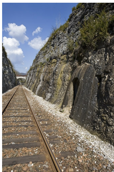
Vue d'ensemble de la tranchée, depuis le côté La Cluse (sud). A droite le cinquième abri. Phot. Yves Sancey IVR43_20073900138NUCA
