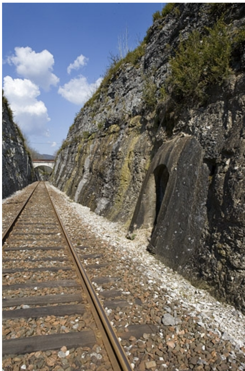
Vue d'ensemble de la tranchée, depuis le côté La Cluse (sud). A droite le cinquième abri.
