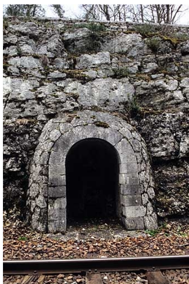
Deuxième abri (à droite de la voie). Phot. Yves Sancey IVR43_20053900911ZA
