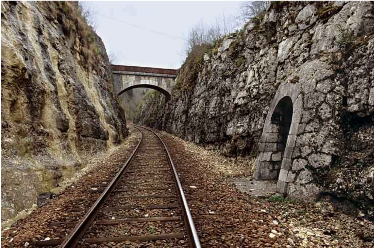
Vue d'ensemble de la tranchée, depuis le côté Andelot-en-Montagne (nord). A droite le deuxième abri, à l'arrière-plan le pont au PK 094.061.
