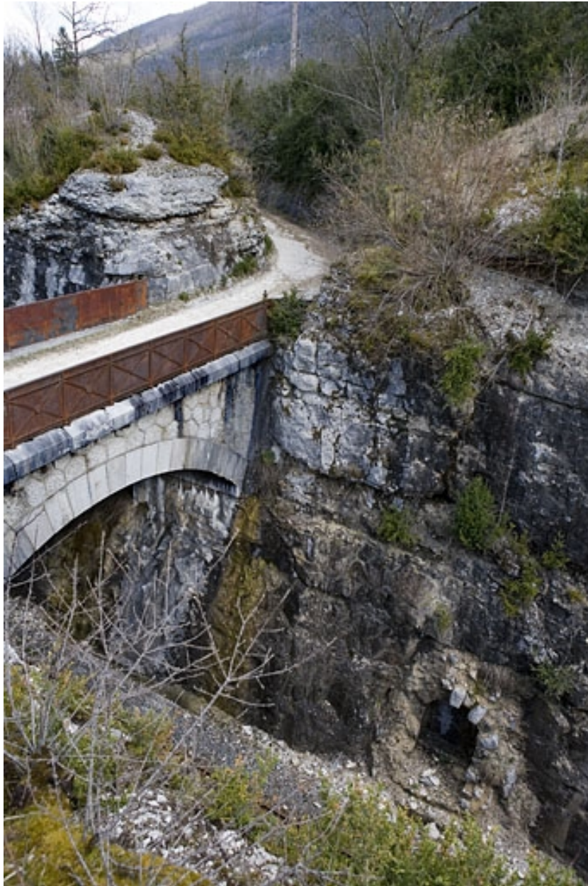
Vue plongeante sur le troisième abri (à gauche de la voie) et sur le pont.
