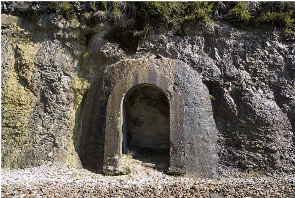
Cinquième abri (à gauche de la voie).
