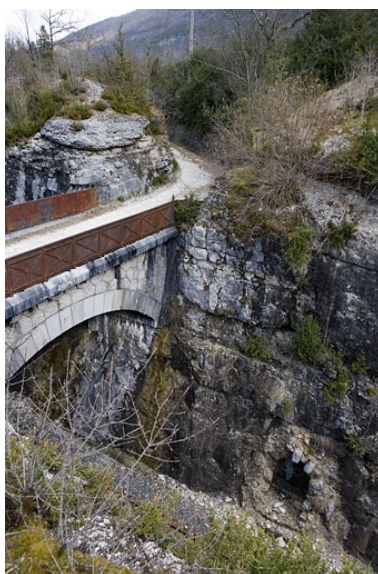
Vue plongeante sur le troisième abri (à gauche de la voie) et sur le pont. Phot. Yves Sancey IVR43_20073900140NUCA
