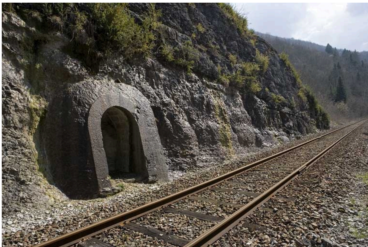
Cinquième abri (à gauche de la voie), de trois quarts gauche.
