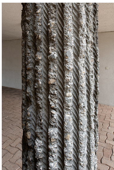
Colonne, détail : empreintes de cordes de chanvre placées en fond du coffrage. Phot. Nicolas Waltefaugle IVR26_20262100116NUC4
