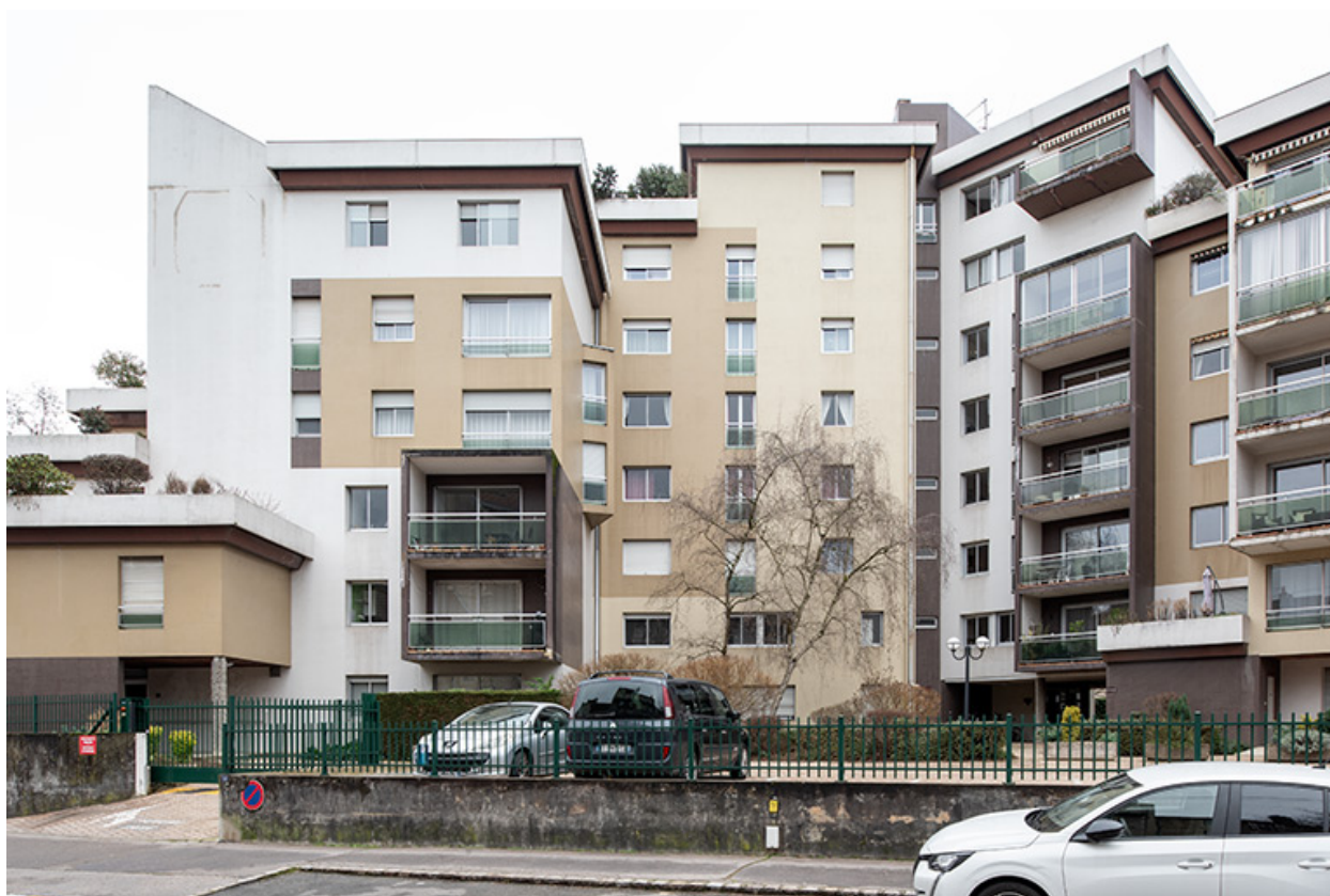
Aile nord, façade est.
