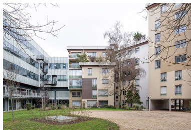
Situation par rapport à l'immeuble de bureaux, vue depuis le sud-ouest.
