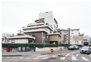
Situation sur le carrefour de la rue Jean-Baptiste-Baudin.
