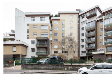
Aile nord, façade est.
