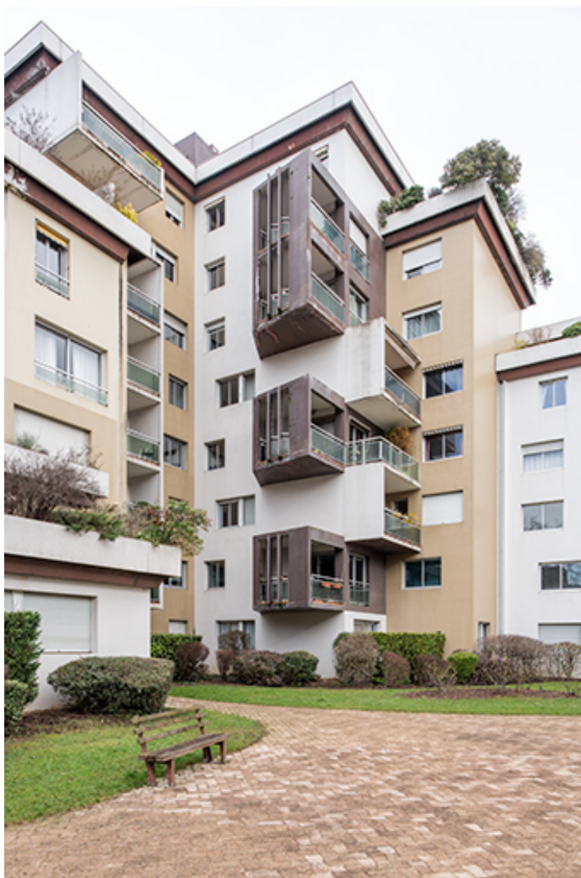
Aile sud-ouest, façade nord-ouest.
