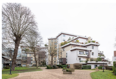
Aile sud-est. Phot. Nicolas Waltefaugle IVR26_20262100120NUC4
