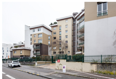
Aile nord, façade est.
