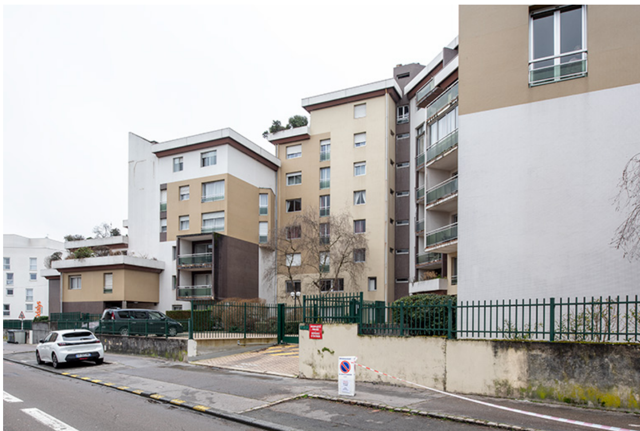
Aile nord, façade est.
