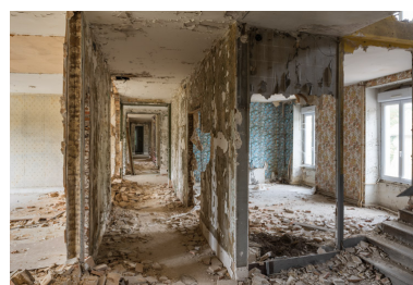
Couloir et chambres au premier étage. Phot. Pierre-Marie Barbe-Richaud IVR26_20195800576NUC4A
