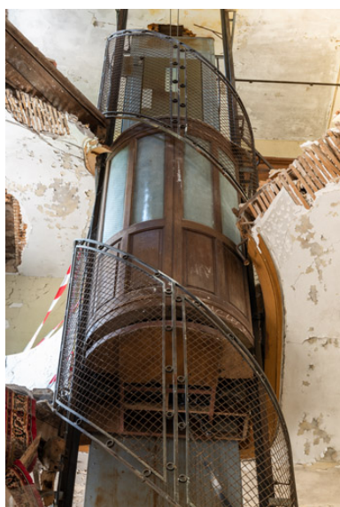
Ascenseur de l'escalier ouest, cabine. Phot. Pierre-Marie Barbe-Richaud IVR26_20195800572NUC4A
