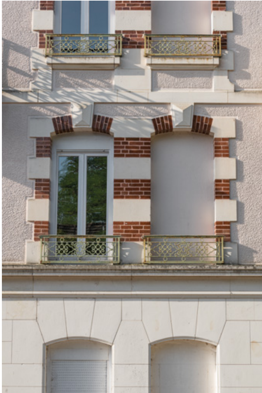
Pavillon occidental, encadrements de baies.
