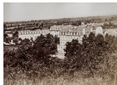
Situation de l'hôtel avec l'Hôtel Bellevue et la Villa Vaux-Martin, vue depuis les Garennes en 1883. Phot. Pierre-Marie Barbe- Richaud, Autr. auteur inconnu IVR26_20195800302NUC4A
