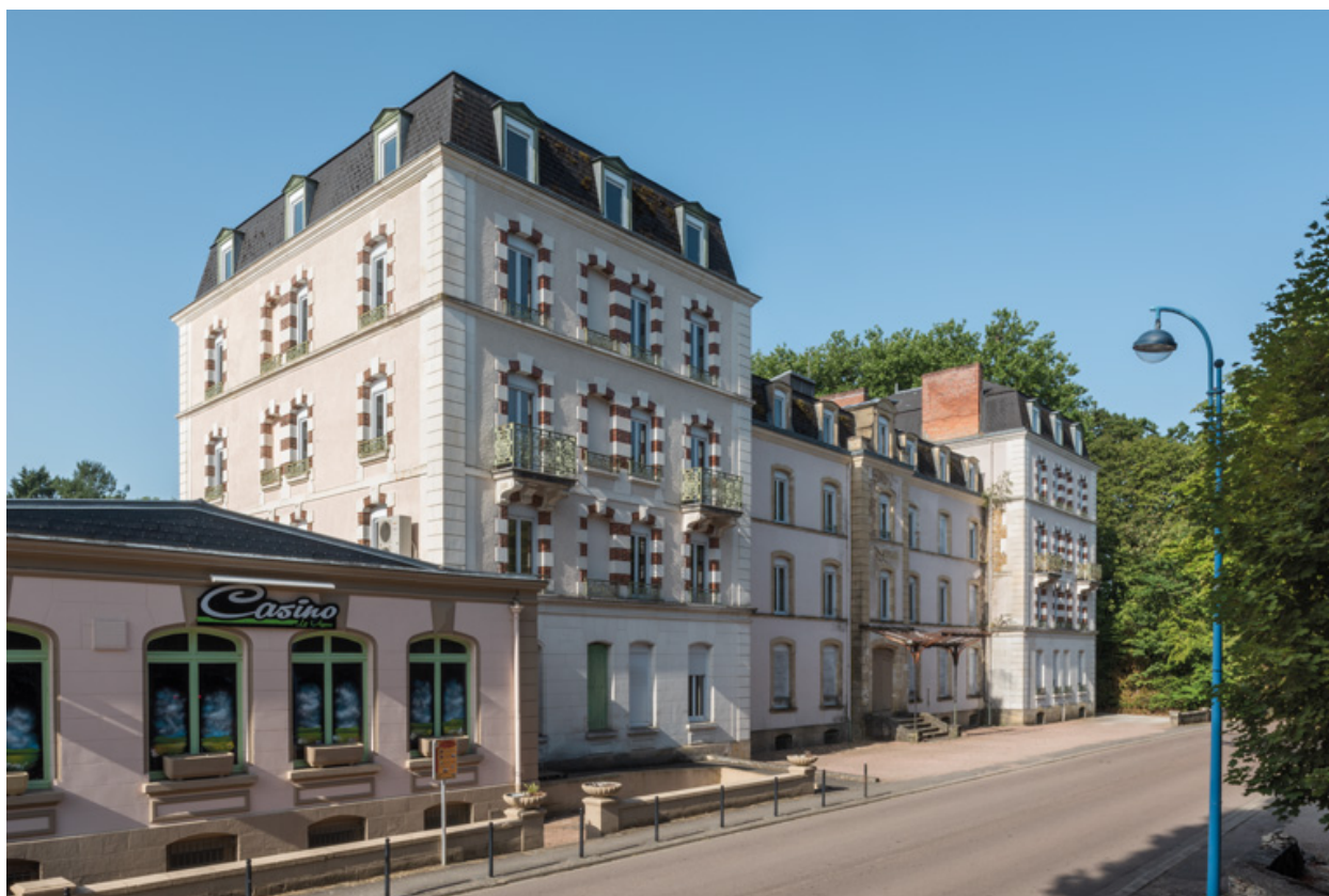
Façade sur l'avenue Jean Mermoz, vue depuis l'est.
