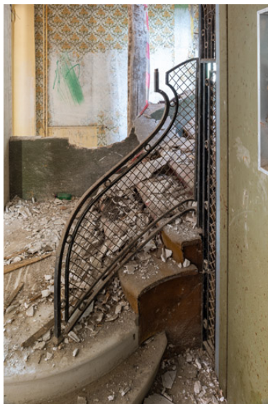
Escalier ouest, détail, rampe d'appui. Phot. Pierre-Marie Barbe-Richaud IVR26_20195800571NUC4A
