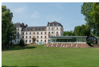
Façade sur le parc. Phot. Pierre-Marie Barbe-Richaud IVR26_20195800368NUC4A
