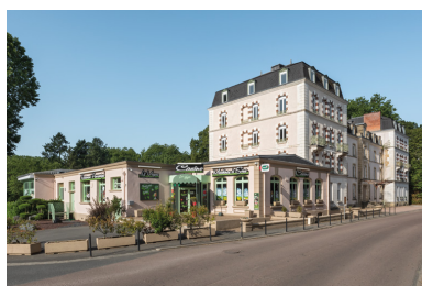
Vue d'ensemble depuis l'avenue Jean Mermoz. Phot. Pierre-Marie Barbe-Richaud IVR26_20195800556NUC4A
