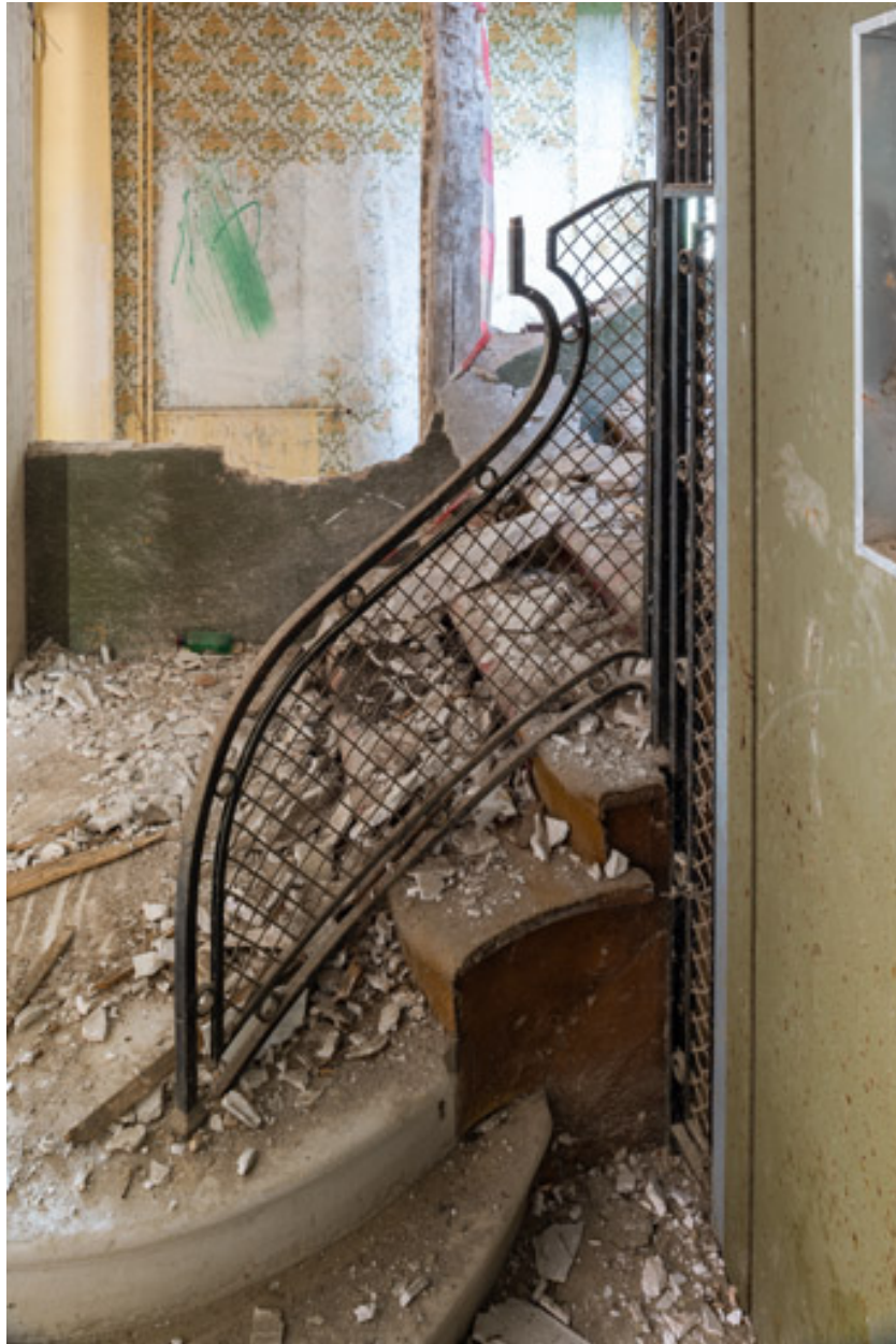
Escalier ouest, détail, rampe d'appui.
