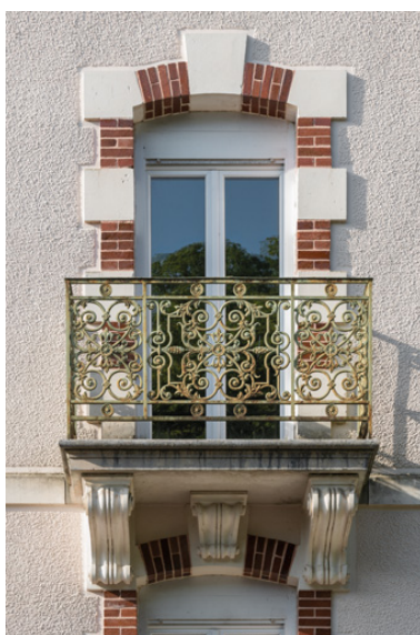
Pavillon occidental, balcon et garde-corps, vue de face. Phot. Pierre-Marie Barbe-Richaud
