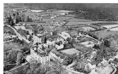
Vue aérienne. Autr. auteur inconnu IVR26_20195800125NUC2A
