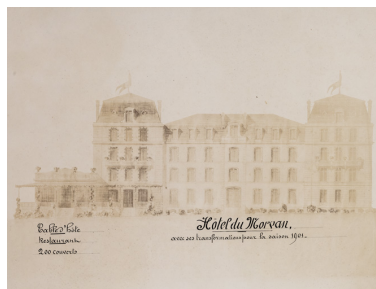
Façade sur le parc après la construction des pavillons latéraux. Phot. Pierre-Marie Barbe- Richaud, Autr. auteur inconnu IVR26_20195800359NUC2A
