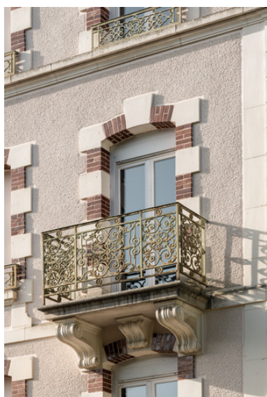
Pavillon occidental, balcon et garde-corps, vue de trois-quarts. Phot. Pierre-Marie Barbe-Richaud
