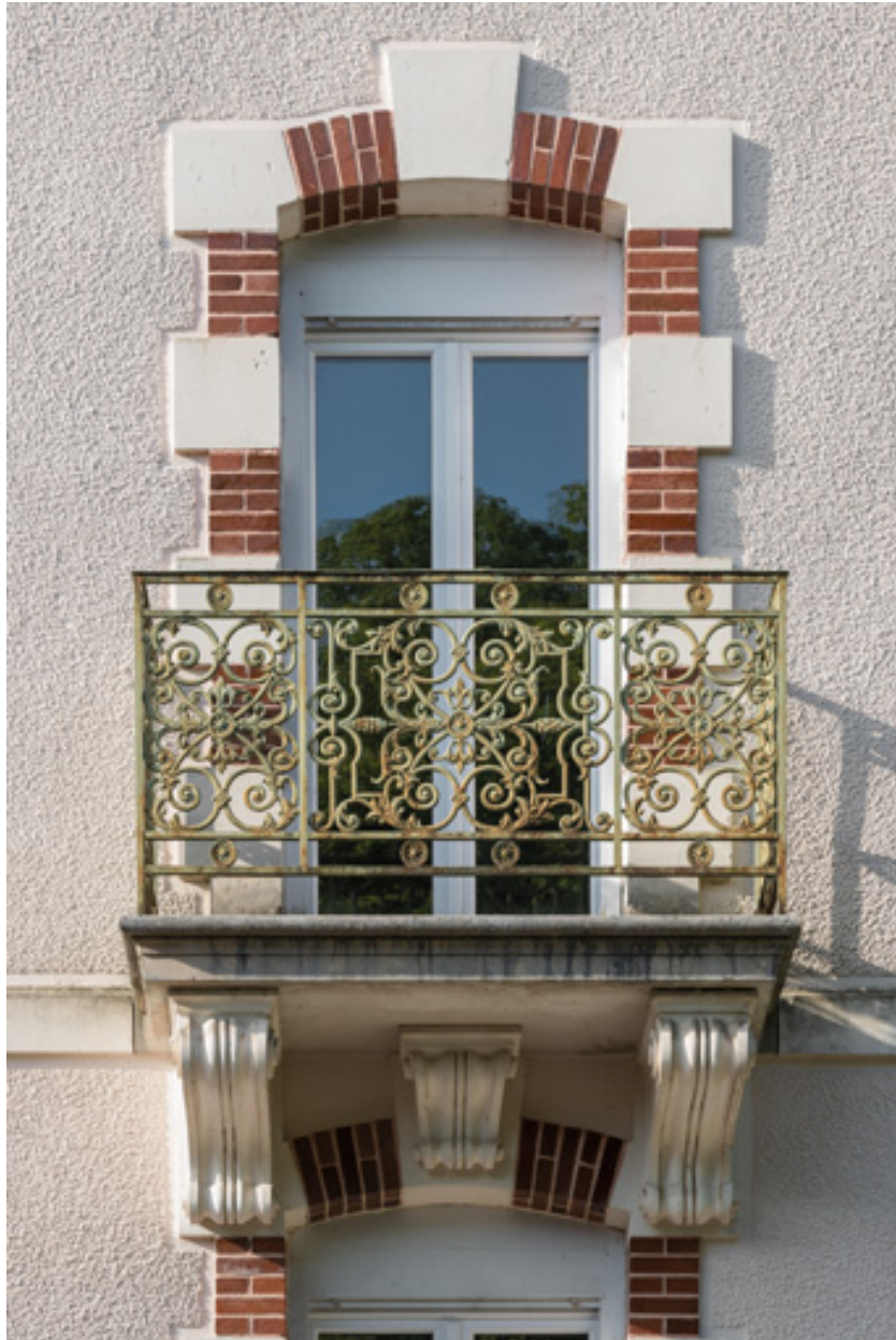
Pavillon occidental, balcon et garde-corps, vue de face.
