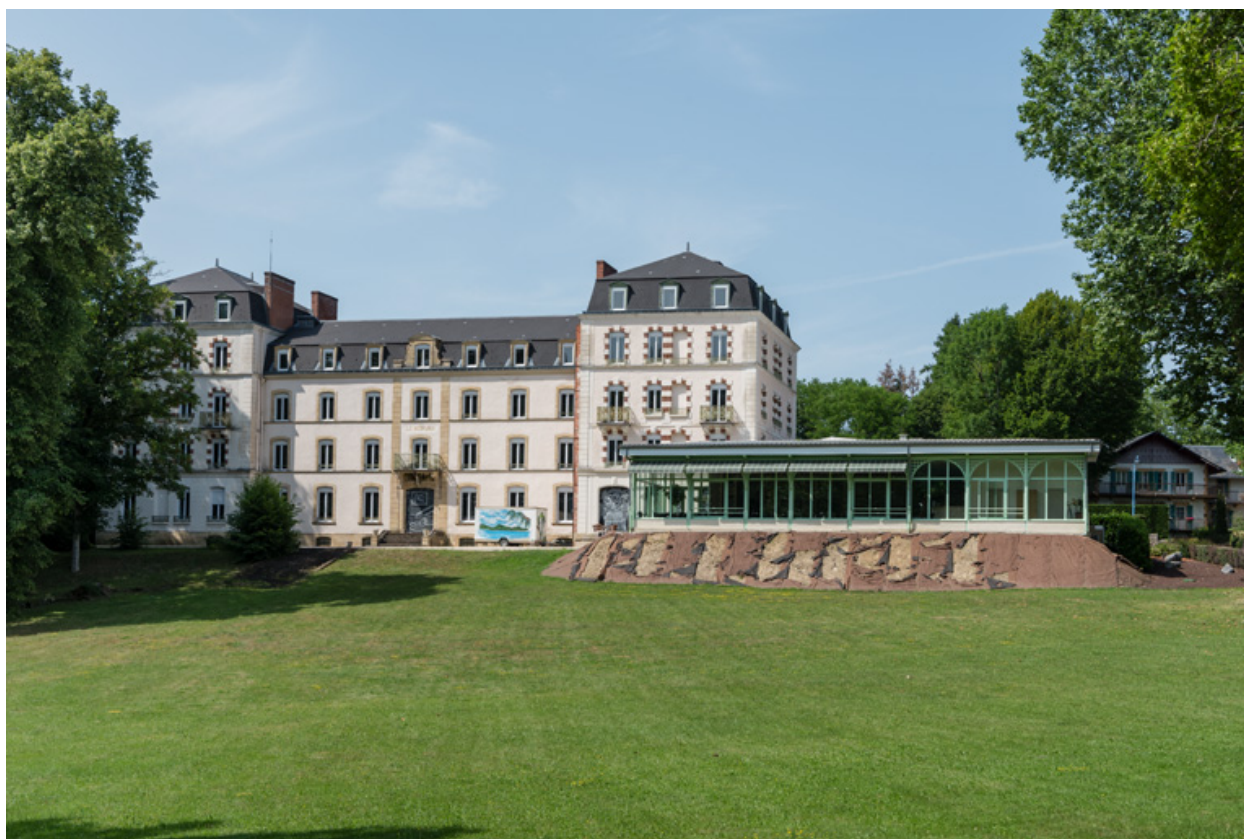
Façade sur le parc.
