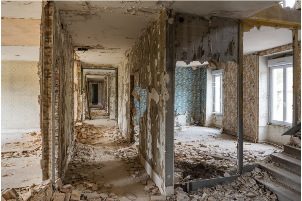
Couloir et chambres au premier étage.
