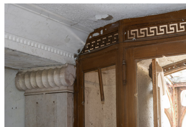
Décor de l'huissierie du sas de l'entrée côté avenue, frise ajourée de grecques. Phot. Pierre-Marie Barbe-Richaud IVR26_20195800575NUC4A
