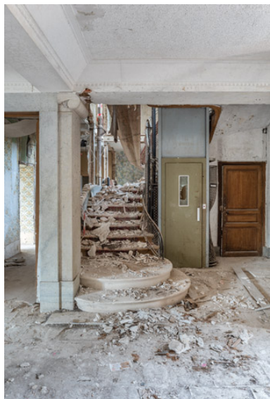
Escalier ouest. Phot. Pierre-Marie Barbe-Richaud IVR26_20195800569NUC4A
