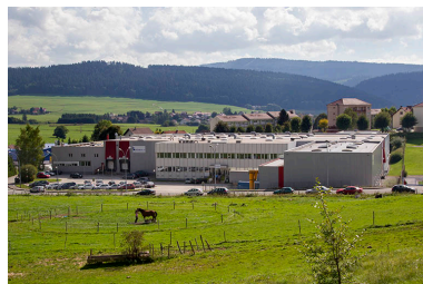
Site récent : vue d'ensemble rapprochée, depuis le nord-ouest. Phot. Yves Sancey IVR43_20132502466NUC2A
