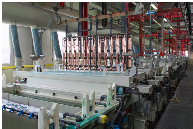
Site ancien : chaîne de chromage. Phot. Yves Sancey IVR43_20132502460NUC2A
