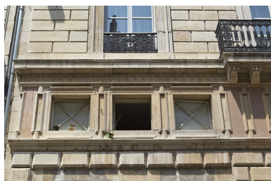
Façade antérieure : détail de l'entresol.
