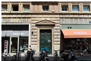
Façade antérieure : détail du rez-de-chaussée, de face.
