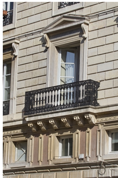
Façade latérale droite : détail du balcon.
