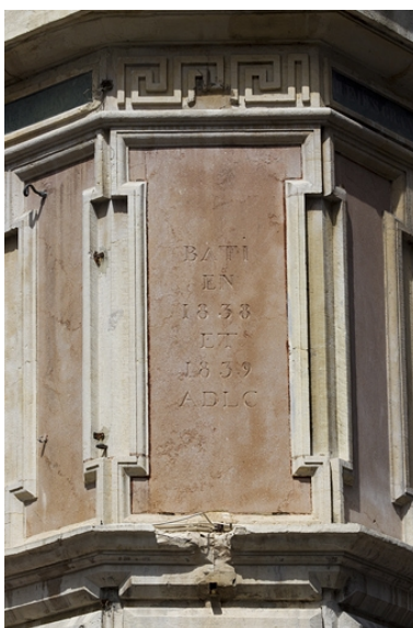
Angle du bâtiment : détail de l'inscription.
