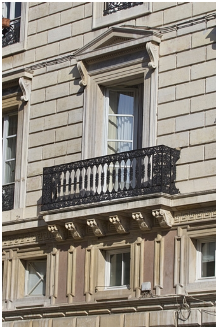
Façade latérale droite : détail du balcon.
