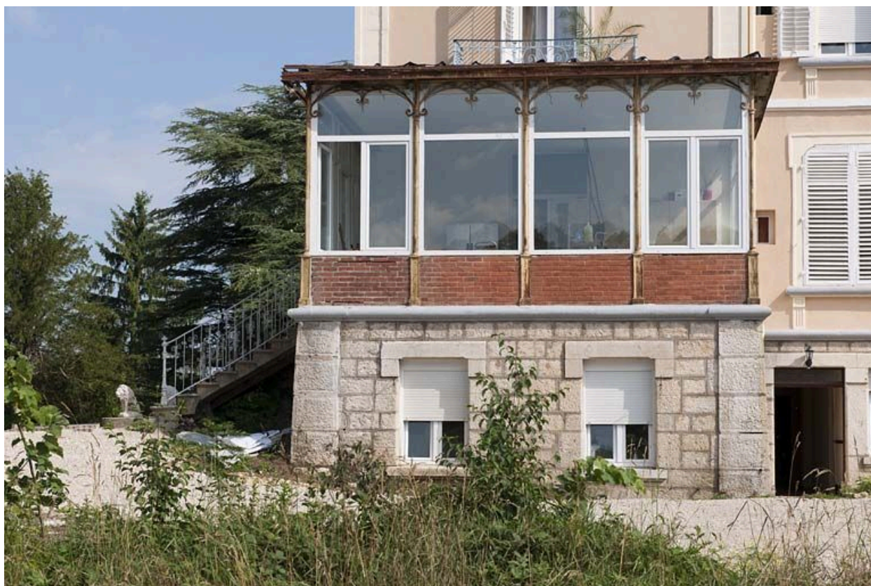
Détail de la véranda.
