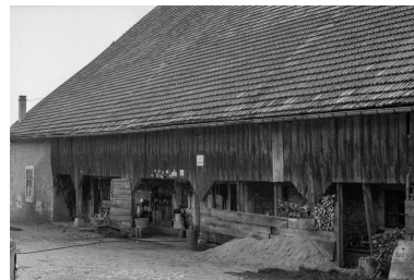
Mur gouttereau droit. Phot. Gilbert Poinso IVR43_19752501319Z
