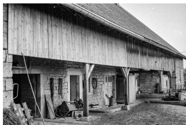
Mur gouttereau gauche. Phot. Gilbert Poinso IVR43_19752501320Z
