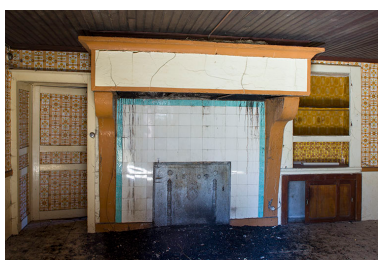
La cheminée et sa plaque. Phot. Sonia Dourlot IVR43_20157000611NUC2A
