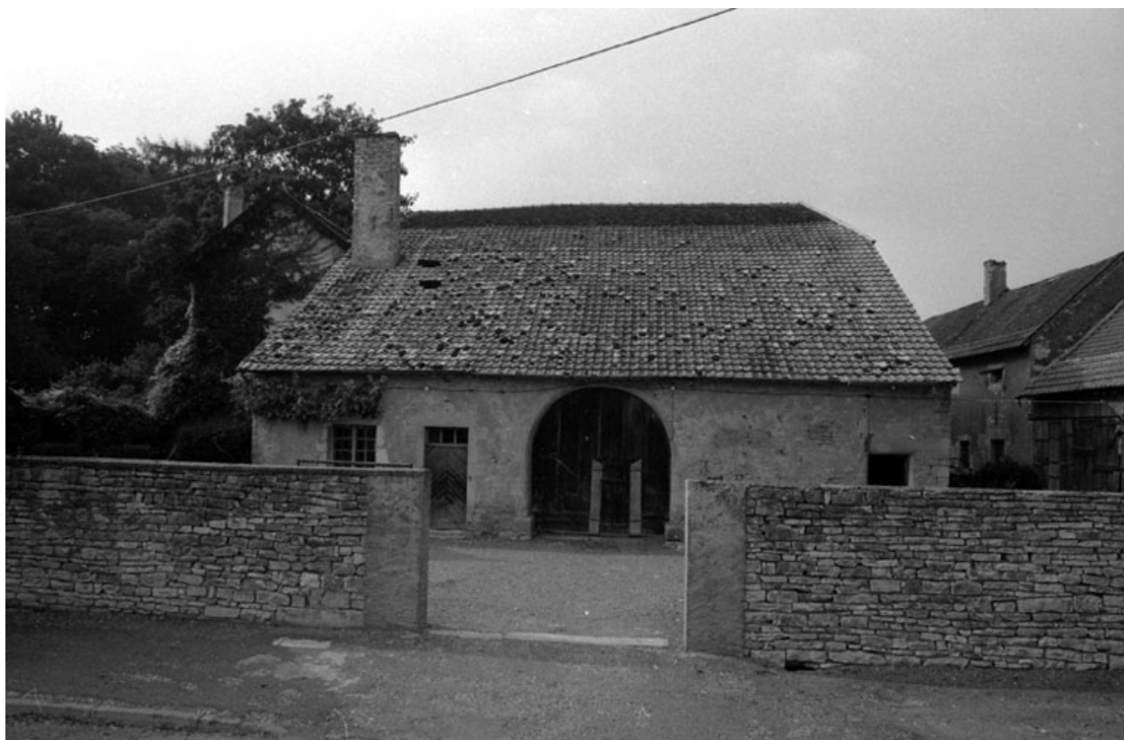
Partie agricole : façade antérieure.
