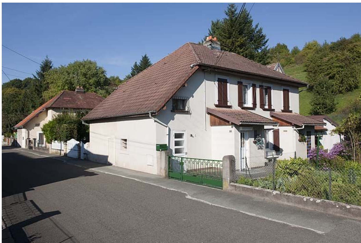
Maisons rue des Graviers. Vue de trois quarts
