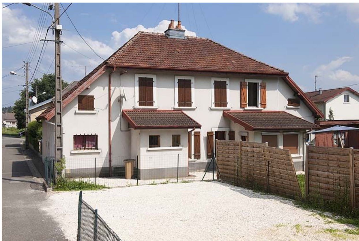
Façade ouest d'une maison.
