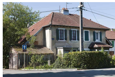
Maison rue des Gravieres vue de trois quarts droite. Phot. Jérôme Mongreville IVR43_20112502398NUC4A
