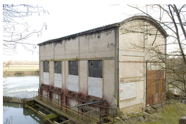
Centrale hydroélectrique rue du Moulin. Phot. Jérôme Mongreville IVR43_20097000247NUC2A
