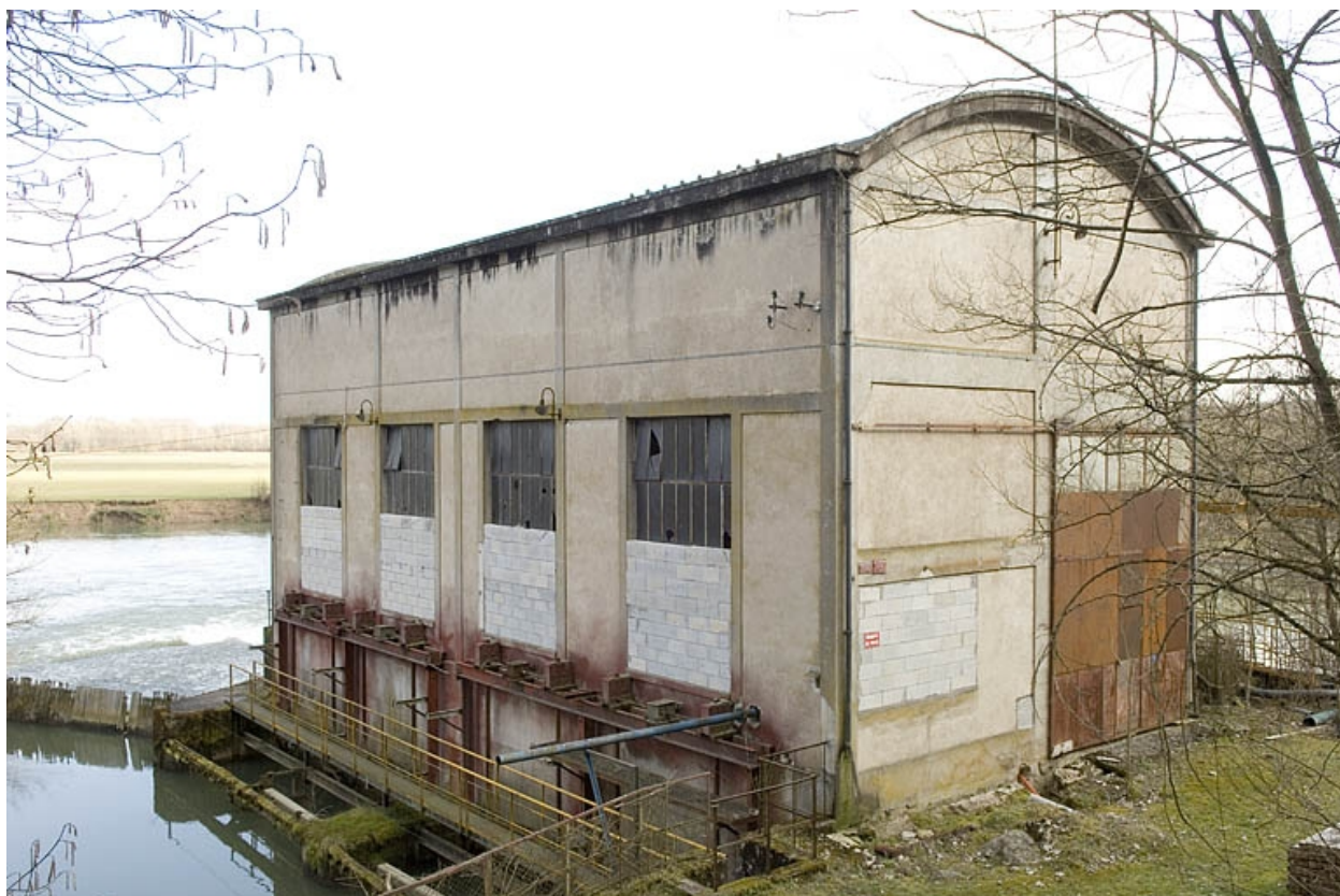
Centrale hydroélectrique rue du Moulin.
