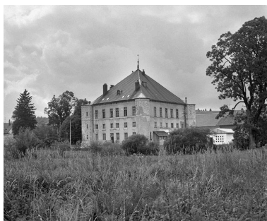
Façade postérieure et latérale gauche. Phot. Yves Sancey IVR43_19782500447X
