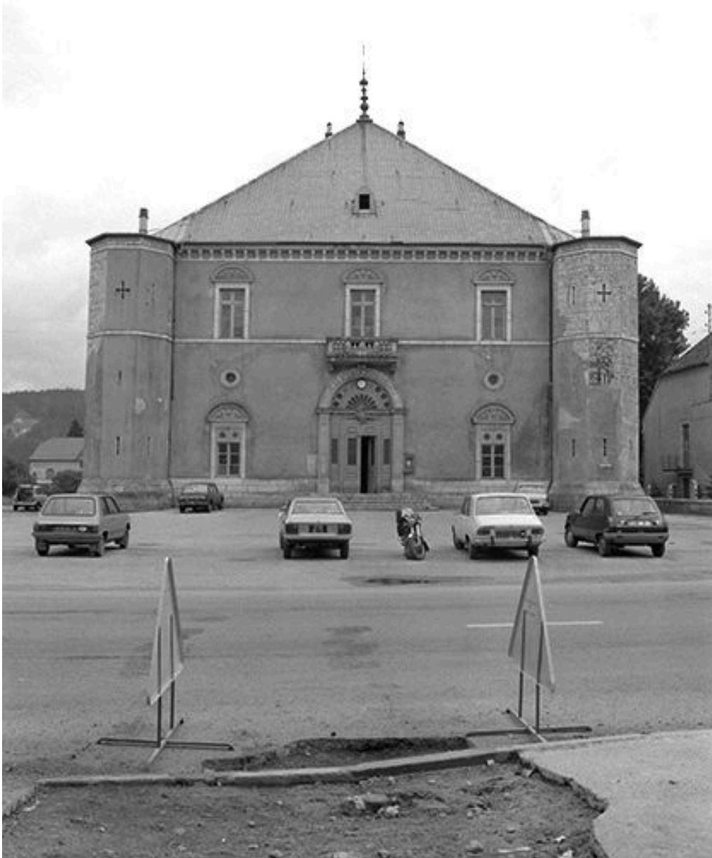
Façade antérieure, vue de face.
