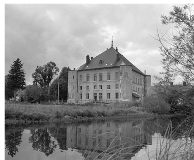
Façade postérieure et latérale gauche. Phot. Yves Sancey IVR43_19782500446X
