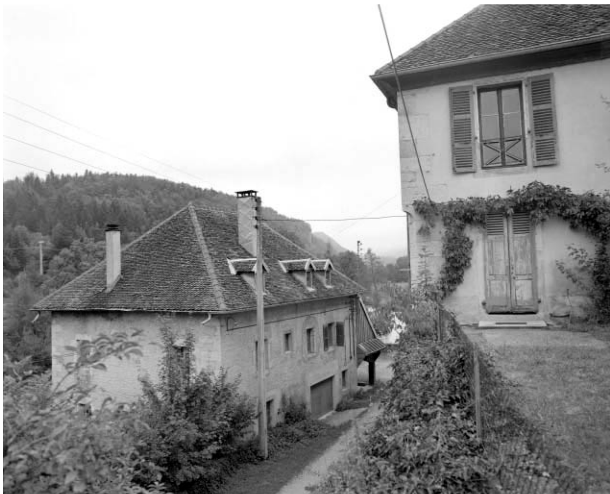
Moulin : façades antérieure et latérale droite.
