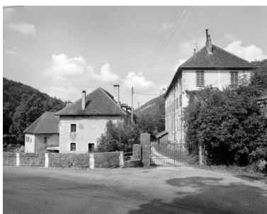
Entrée du site. Phot. Yves Sancey IVR43_19923900846X
