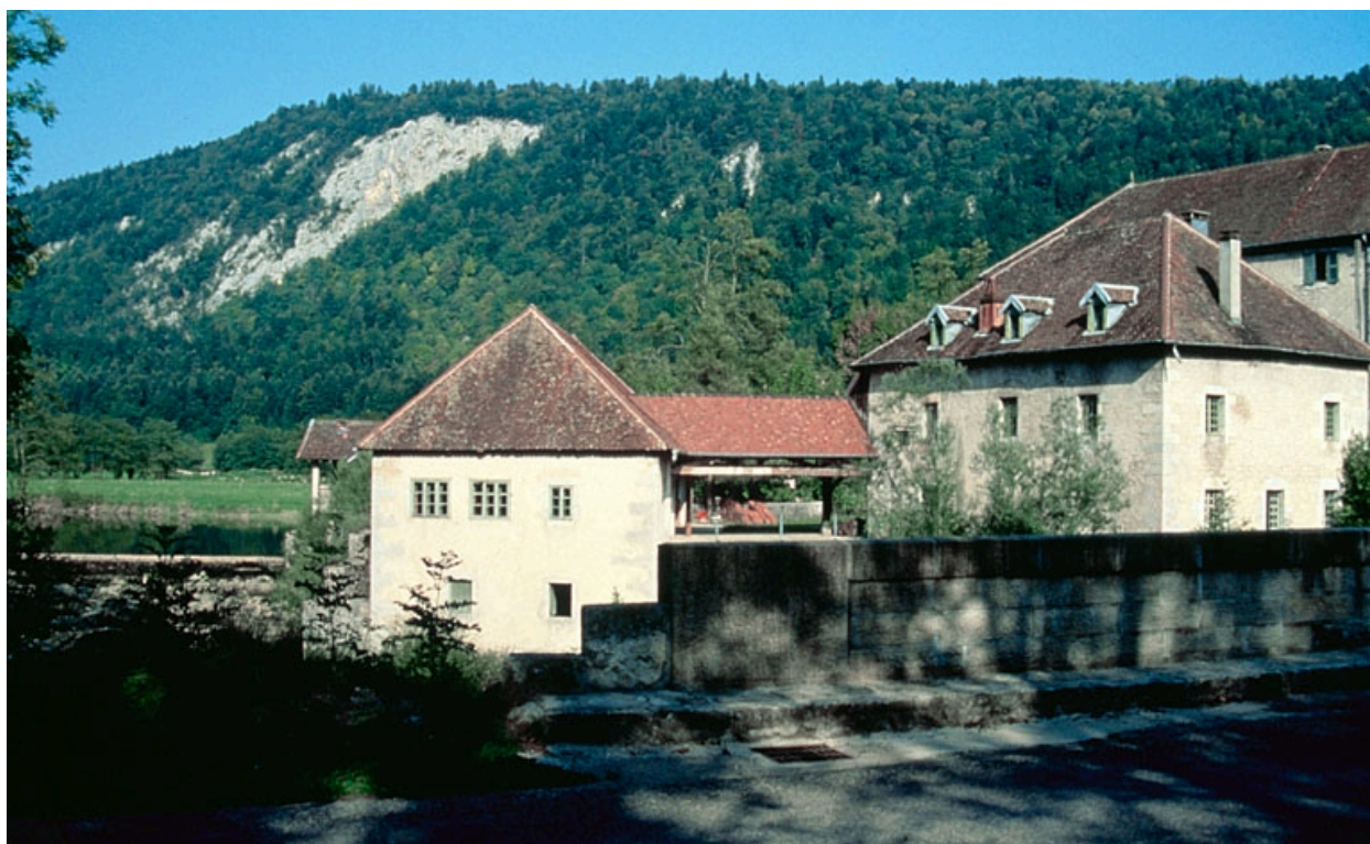
Vue d'ensemble depuis le pont, à l'ouest.
