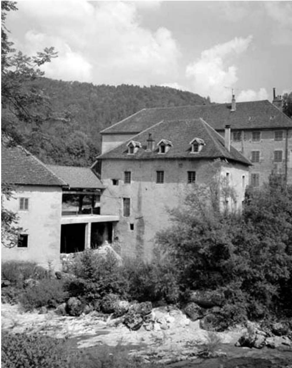
Moulin : façade latérale gauche.
