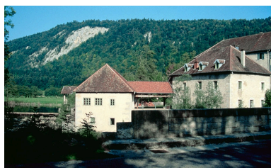
Vue d'ensemble depuis le pont, à l'ouest. Phot. Yves Sancey IVR43_19923900852ZA
