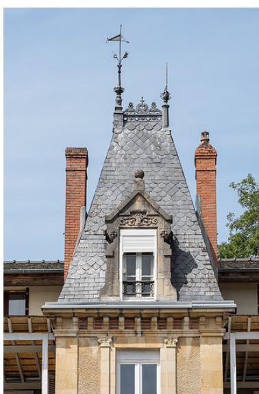
Toit à quatre pans en ardoise de la tour avec crête et épi de faitage. Phot. Pierre-Marie Barbe-Richaud IVR26_20195800677NUC4A
