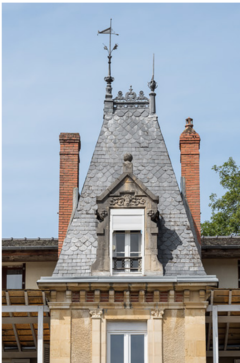
Toit à quatre pans en ardoise de la tour avec crête et épi de faitage.
