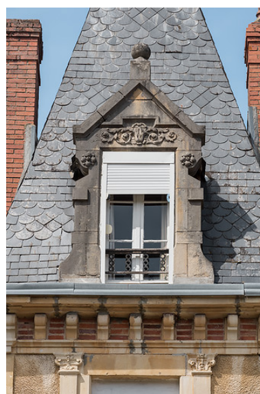
Lucarne en pierre sculptée de la tour. Phot. Pierre-Marie Barbe-Richaud IVR26_20195800678NUC4A
