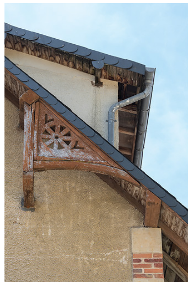
Pignon nord-est, éléments de charpente apparente (sous-arbalétriers, cercles). Phot. Pierre-Marie Barbe-Richaud IVR26_20195800674NUC4A
