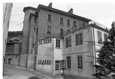
Façade postérieure et atelier sur la rue Fenandre. Phot. Laurent Poupard IVR43_19913901465Z
