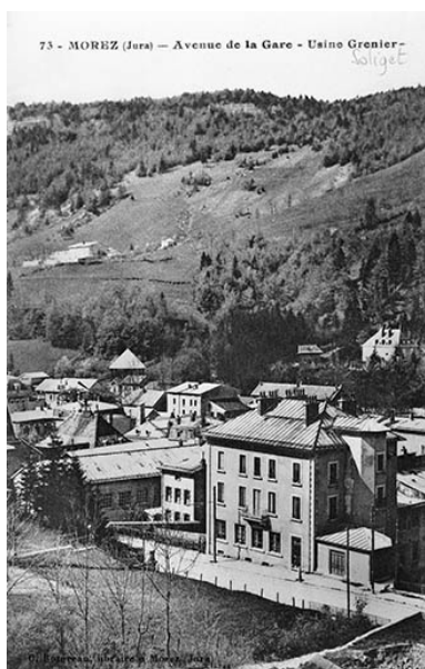
Morez (Jura) - Avenue de la Gare - Usine Grenier. Phot. IVR43_19913900230X
