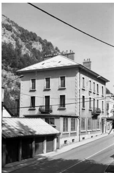
Façades antérieure et latérale gauche. Phot. Jérôme Mongreville IVR43_19913901463Z
