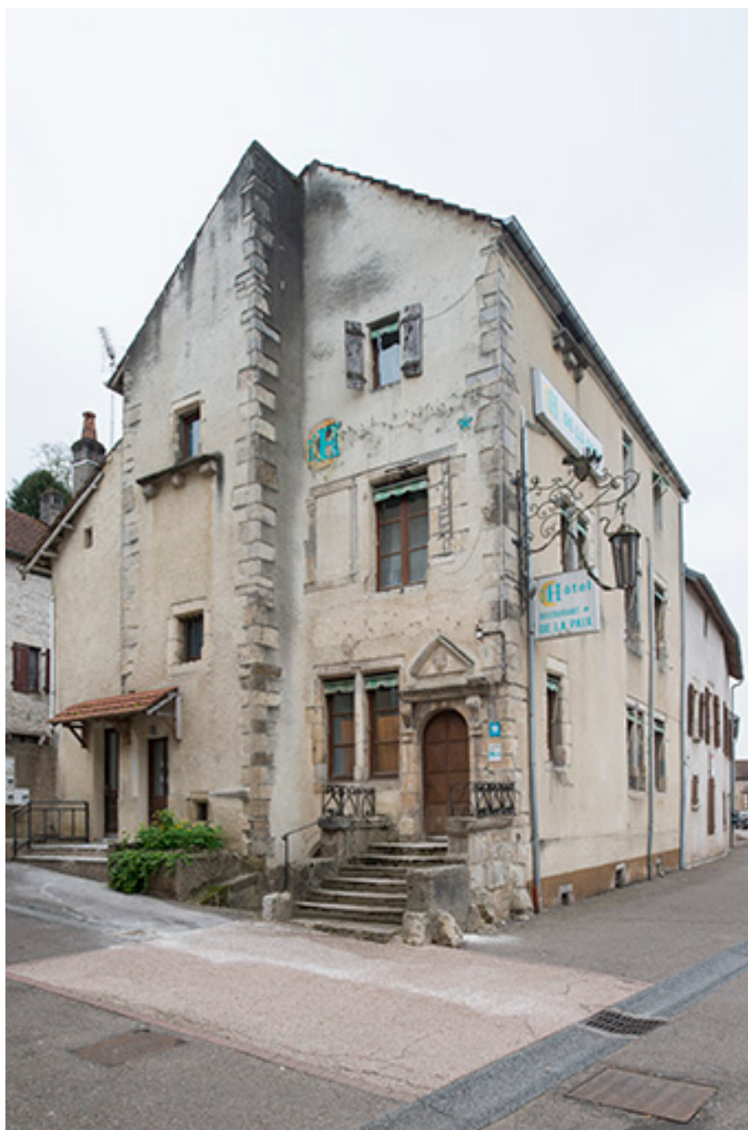
Vue générale depuis la rue Jean Bogé.
