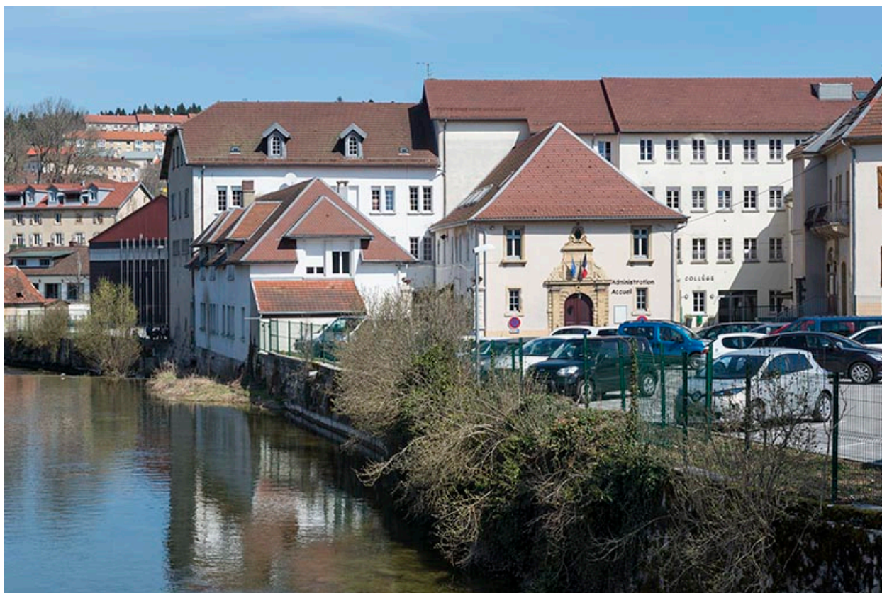
Vue rapprochée depuis le sud-ouest.
