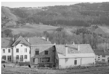
Façade postérieure. Phot. Laurent Poupard IVR43_19913901033Z
