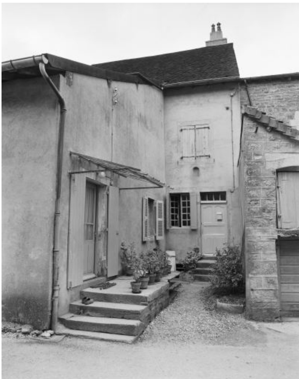
Façade sur la rue de la Forge.
