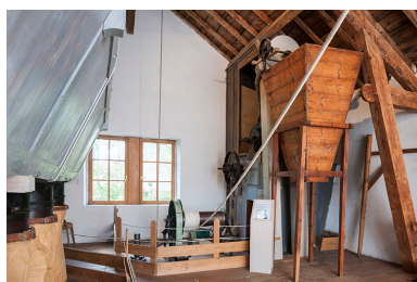
Troisième étage. Vue d'ensemble. Phot. Jérôme Mongreville IVR43_20162500270NUC4A
