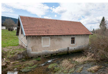
Ancienne forge. Façade nord. Phot. Jérôme Mongreville IVR43_20162500267NUC4A
