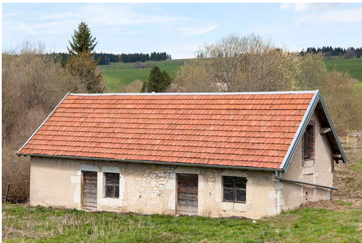
Ancien atelier de forge. Façade sud.
