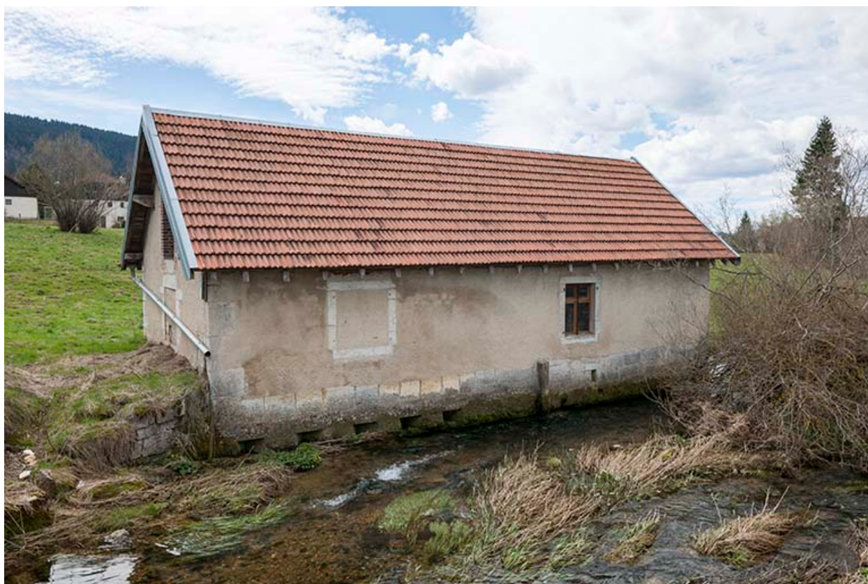
Ancienne forge. Façade nord.
