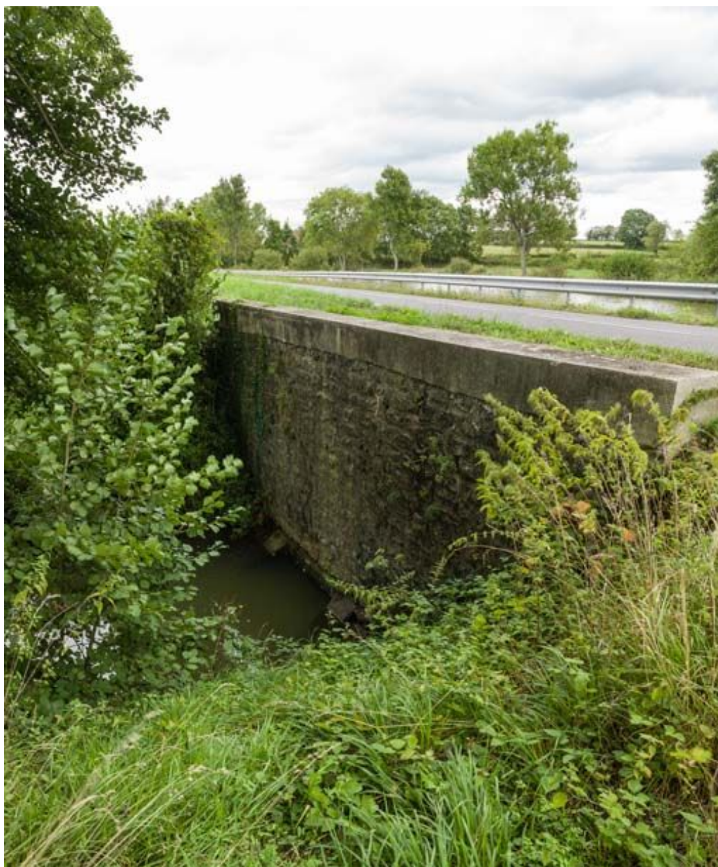
Vue de l'aqueduc.
