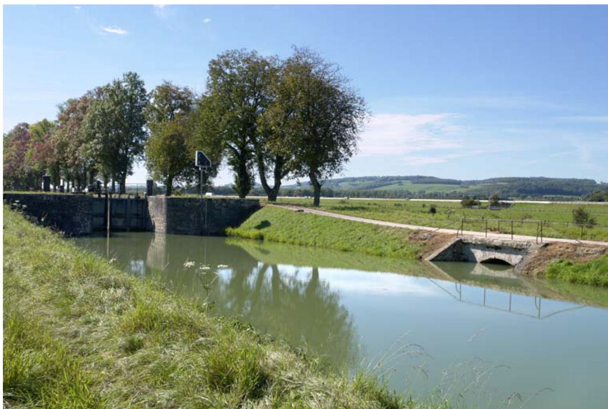
Embouchure de la prise d'eau dans le bief.
