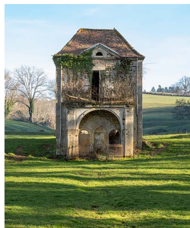
Pavillon de la source, vue de face. Phot. Pierre-Marie Barbe-Richaud IVR26_20207100791NUC2A
