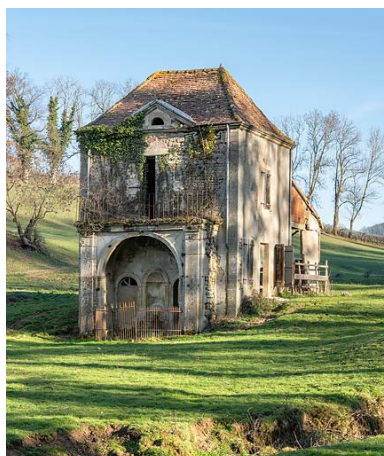
Pavillon de la source, vue de trois quarts. Phot. Pierre-Marie Barbe-Richaud IVR26_20207100789NUC2A
