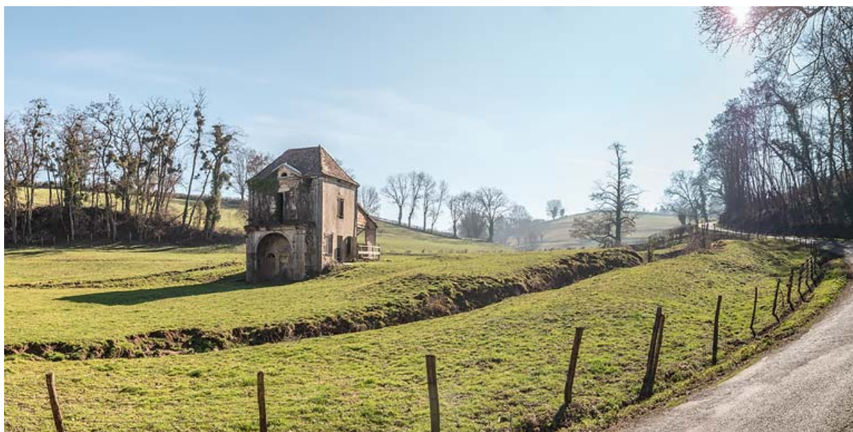
Vue générale du site, prise depuis la route (vue de l'avant du pavillon de la source).
