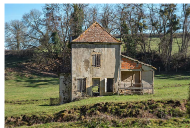
Pavillon de la source, vue latérale. Phot. Pierre-Marie Barbe-Richaud IVR26_20207100783NUC4A
