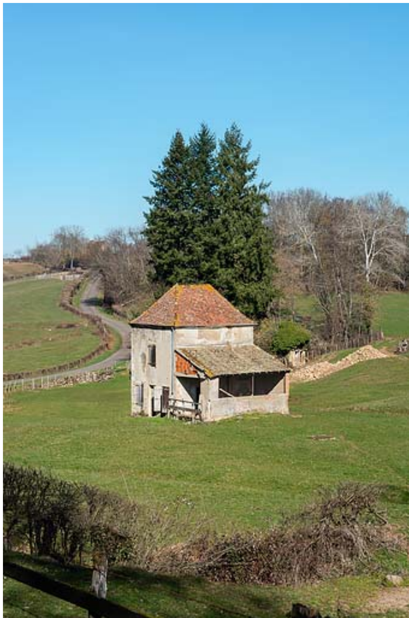
Vue générale du site, prise depuis la route (vue de l'arrière du pavillon de la source).
