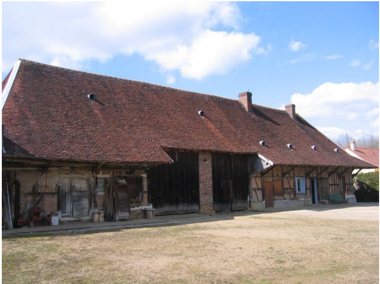
Vue d'ensemble de la façade.
