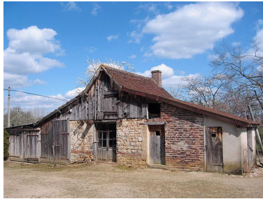
Vue d'ensemble de la façade de l'atelier-four. Phot. Gaëlle Prost IVR26_20087100166NUC1A
