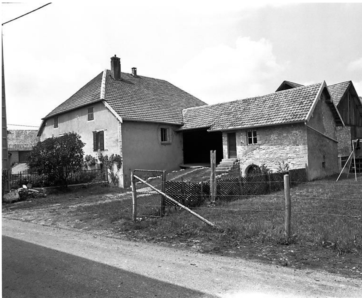
Façade antérieure et face latérale droite.
