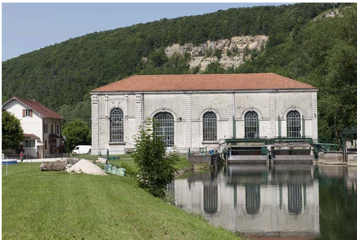
Façade sud de la centrale.
