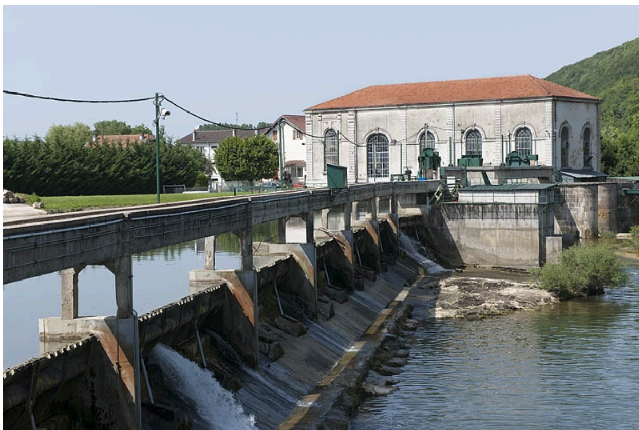
Les déversoirs du barrage et la centrale.
