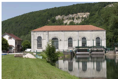
Façade sud de la centrale. Phot. Jérôme Mongreville IVR43_20122501793NUC4A
