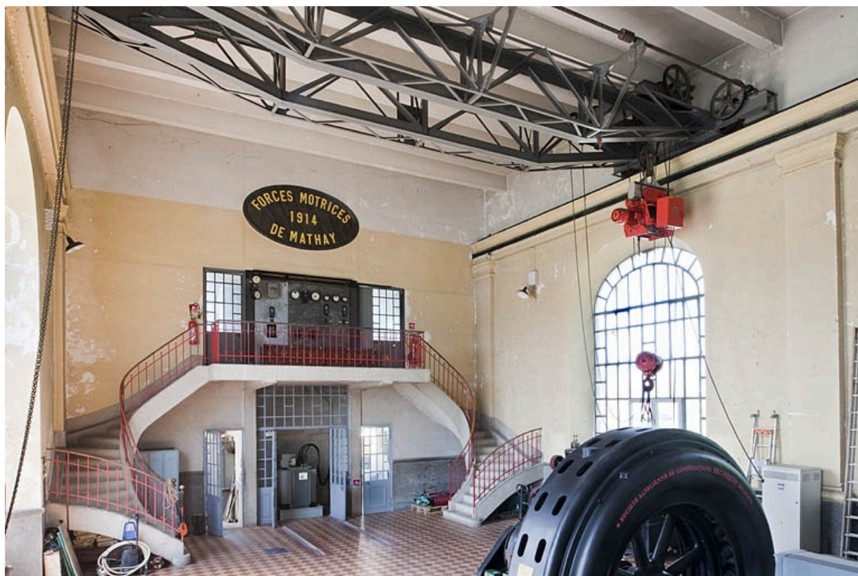
Extrémité nord-ouest de la centrale.
