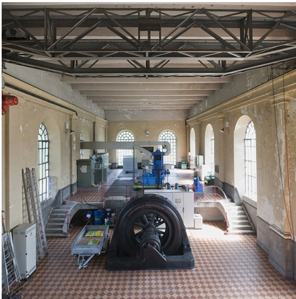
Vue intérieure, depuis le nord-ouest.
