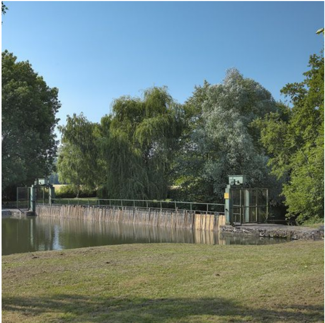
Vue rapprochée du barrage.
