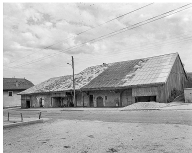
Façade sur rue. Phot. Dominique Dominguez IVR43_19792501043X
