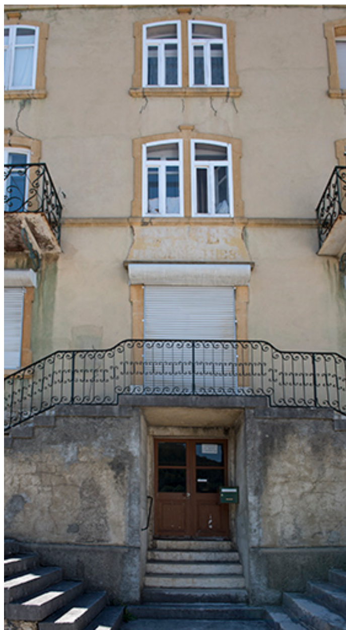
Façade antérieure : travée centrale et escalier.
