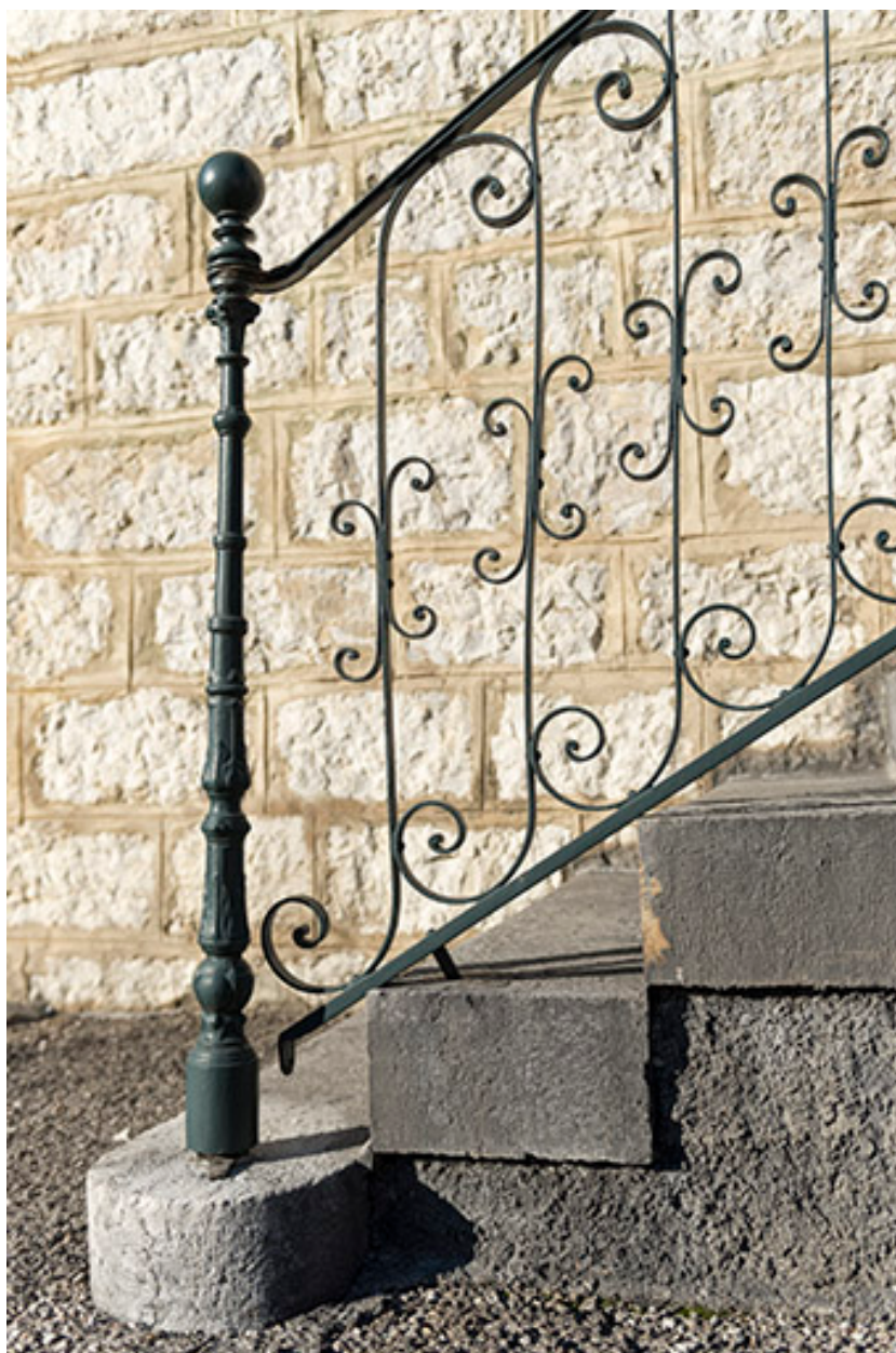
Façade antérieure : garde-corps de l'escalier.
