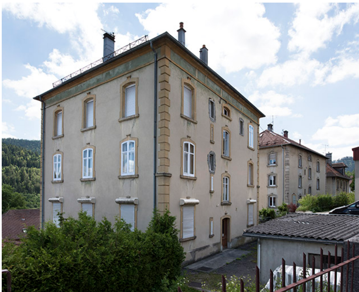
Façades postérieure et latérale droite.
