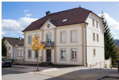
Façades antérieure et latérale droite.
