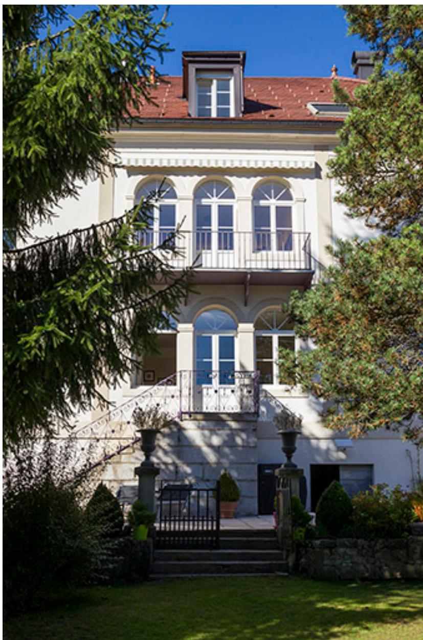
Façade postérieure : travée centrale.
