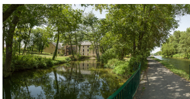
Vue d'ensemble du moulin avec à droite, le canal. Au premier plan, le bief de dérivation.
