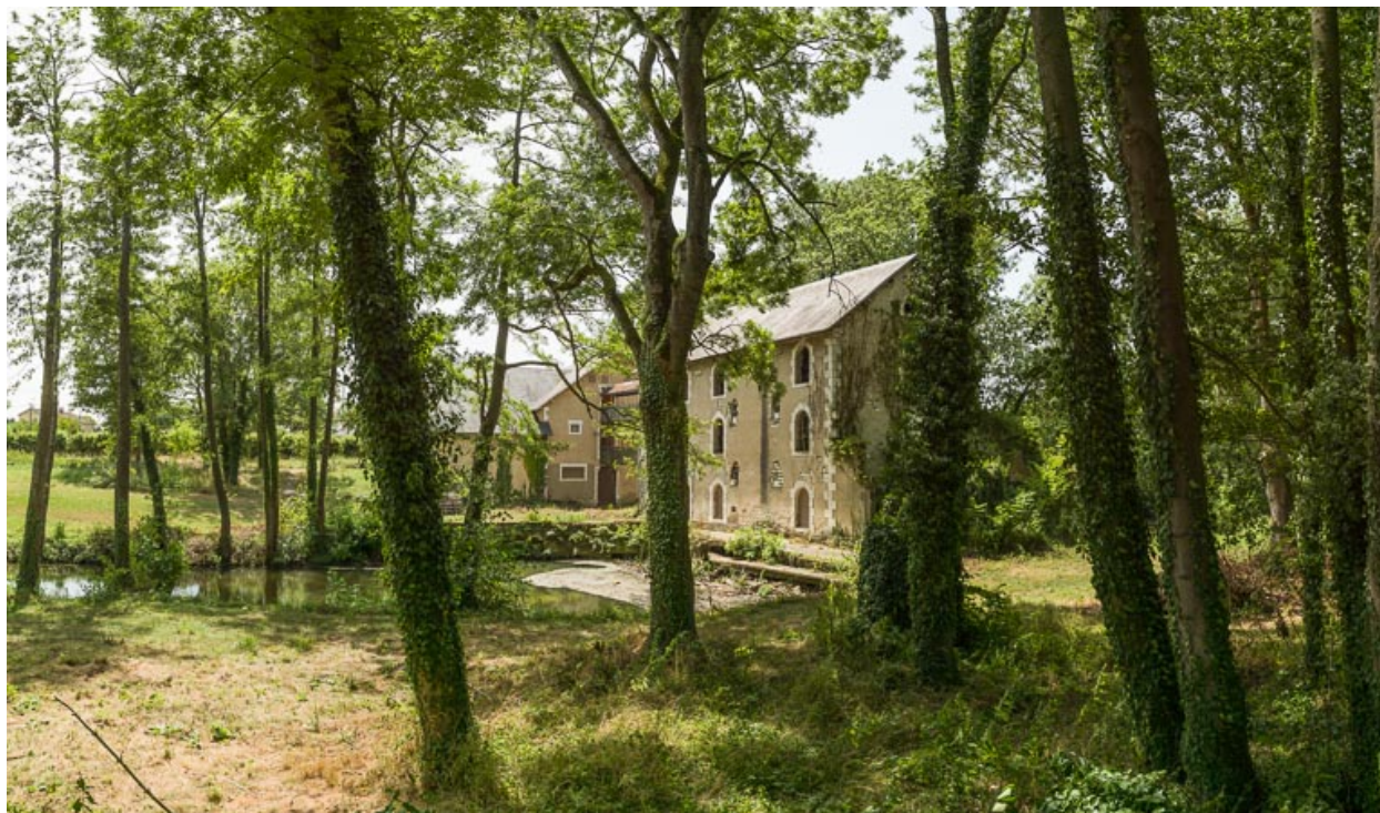
Vue d'ensemble du moulin.
