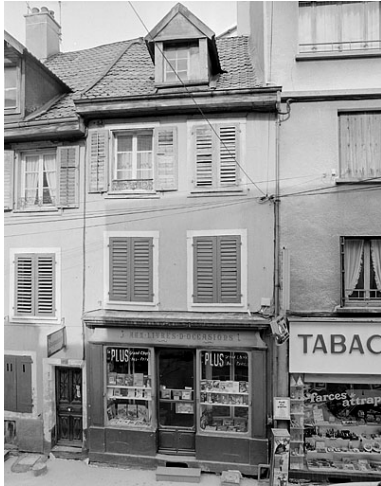
Façade sur rue. Phot. Jérôme Mongreville IVR43_19872500957X
