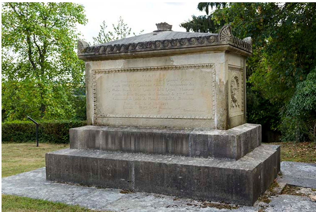
Faces latérale droite (est) et postérieure (nord).
