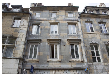
Façade antérieure : détail des étages, de face.
