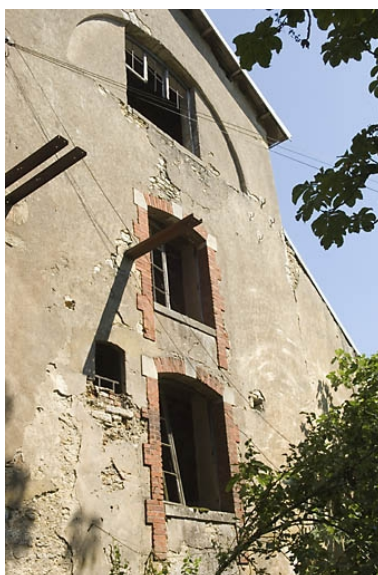
Elévation du pignon sud du haut fourneau. Phot. Jérôme Mongreville IVR43_20087000673NUC2A
