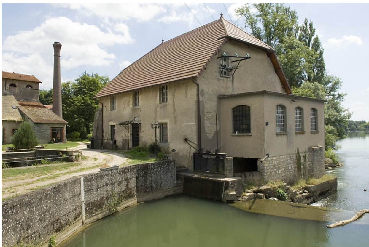
Moulin reconverti en centrale hydroélectrique.
