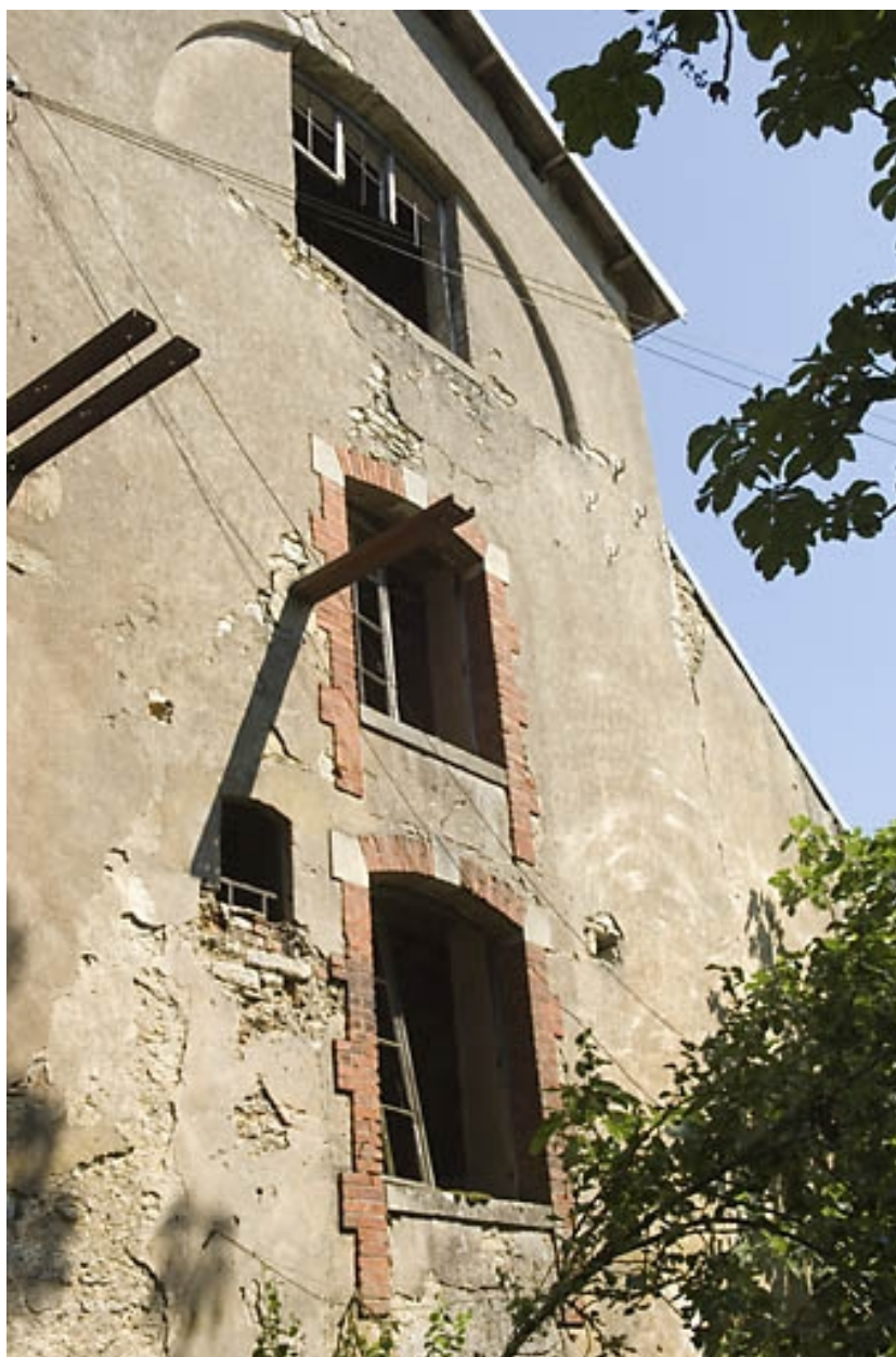
Elévation du pignon sud du haut fourneau.
