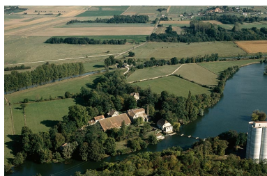
Vue aérienne depuis le nord-ouest en 1989. Phot. Yves Sancey IVR43_19897000589XA
