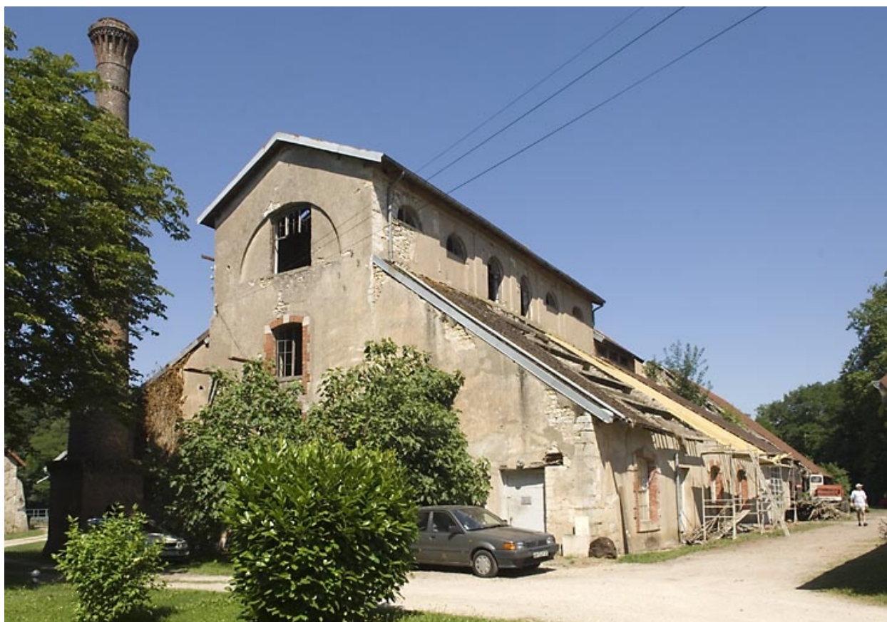
Le haut fourneau vu depuis le sud-est.
