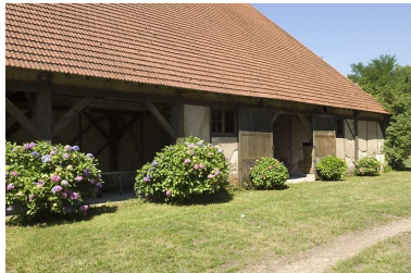
Extrémité nord de la halle à charbon. Phot. Jérôme Mongreville IVR43_20087000677NUC2A
