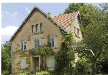
Logement patronal. Phot. Jérôme Mongreville IVR43_20087000690NUC2A
