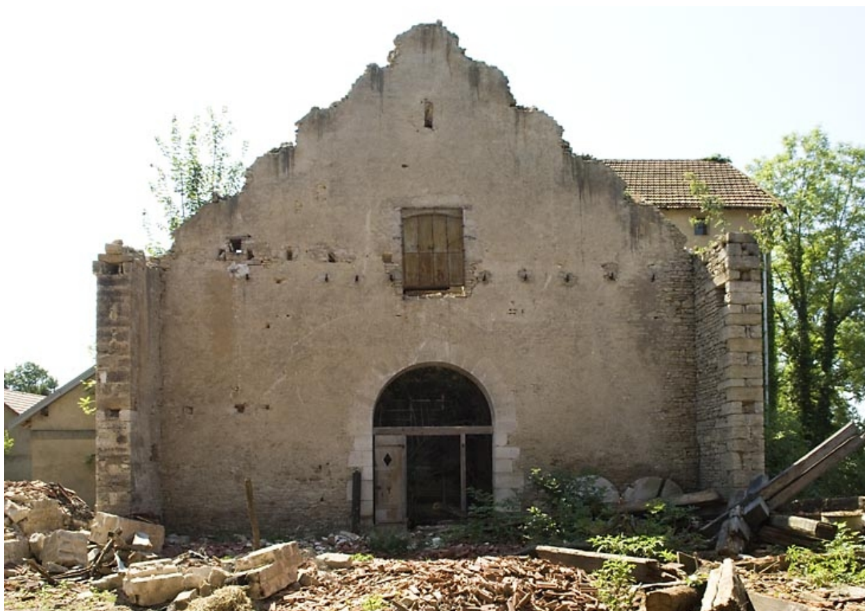
Mur sud de la halle à charbon.
