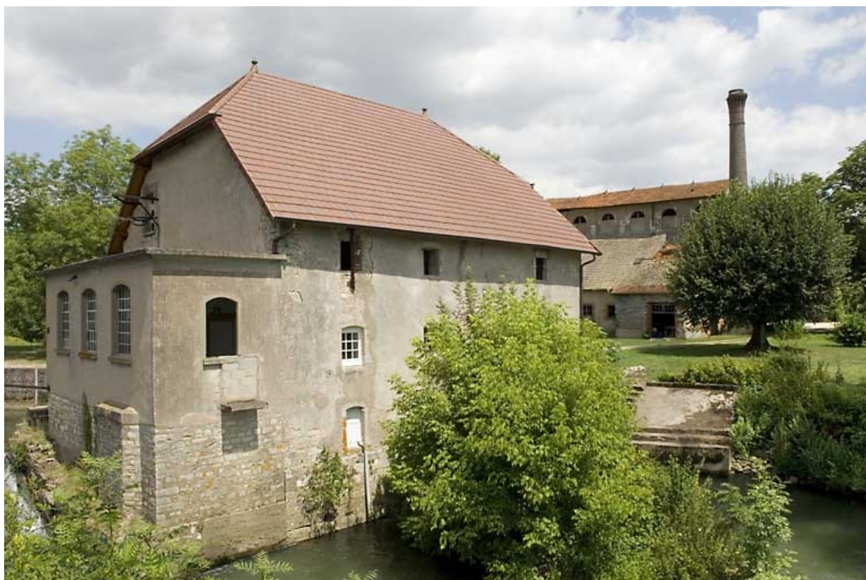
Moulin et haut fourneau depuis le sud-ouest.
