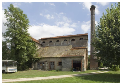
Elévation ouest du haut fourneau. Phot. Jérôme Mongreville IVR43_20087000681NUC2A
