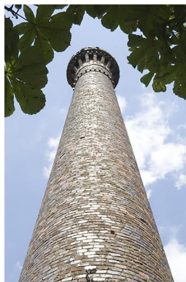
La cheminée. Phot. Jérôme Mongreville IVR43_20087000687NUC2A
