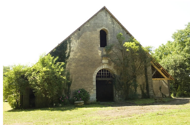
Mur-pignon nord de la halle à charbon. Phot. Jérôme Mongreville IVR43_20087000678NUC2A
