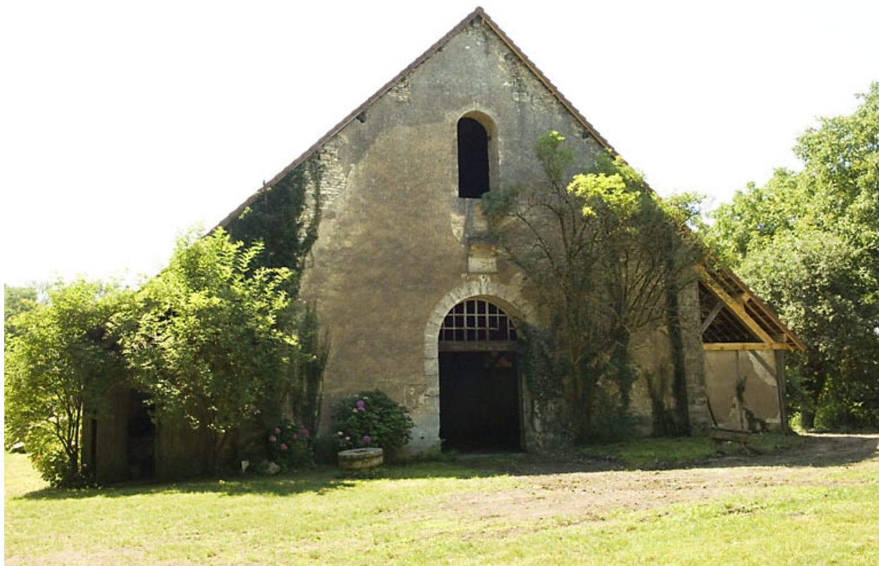
Mur-pignon nord de la halle à charbon.
