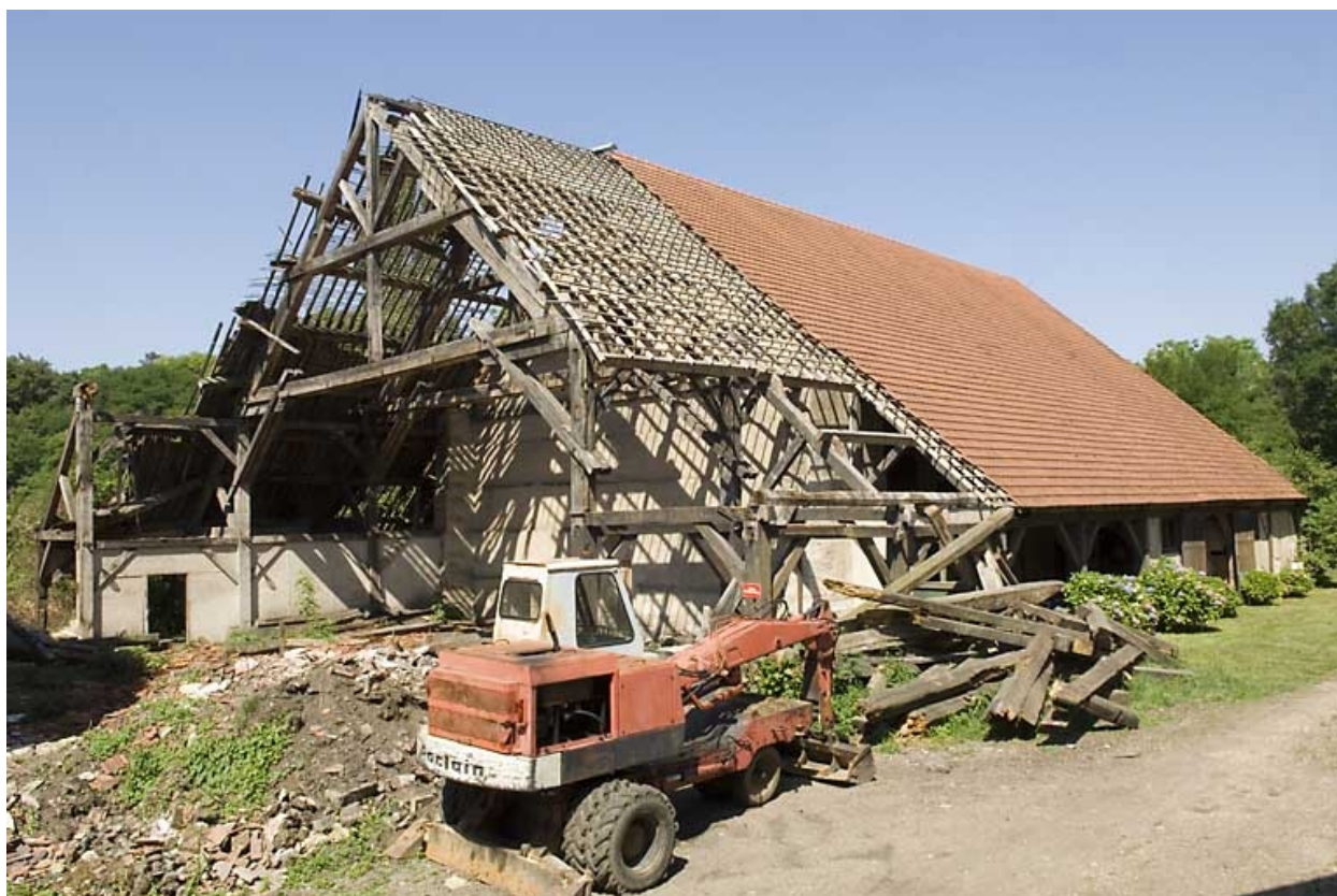
La halle à charbon vue depuis l'est.
