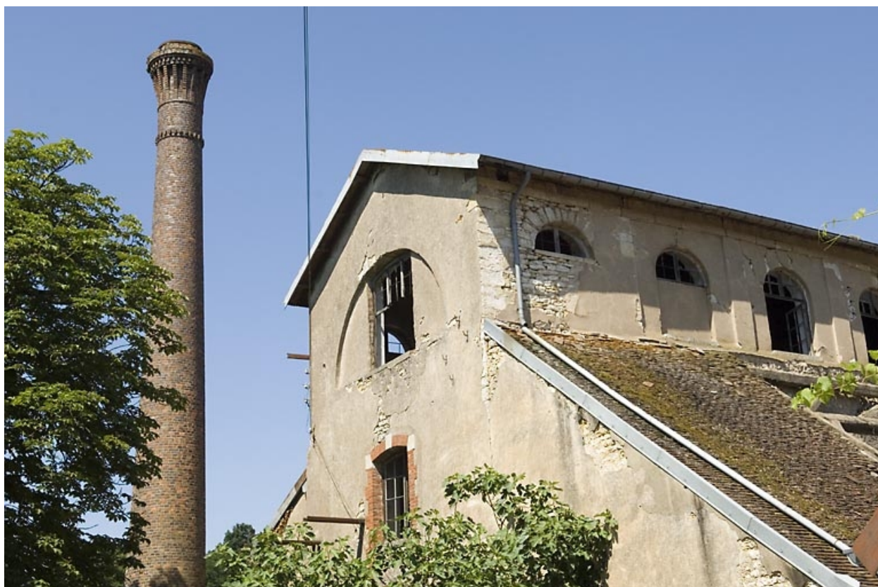
Cheminée et partie supérieure du haut fourneau.
