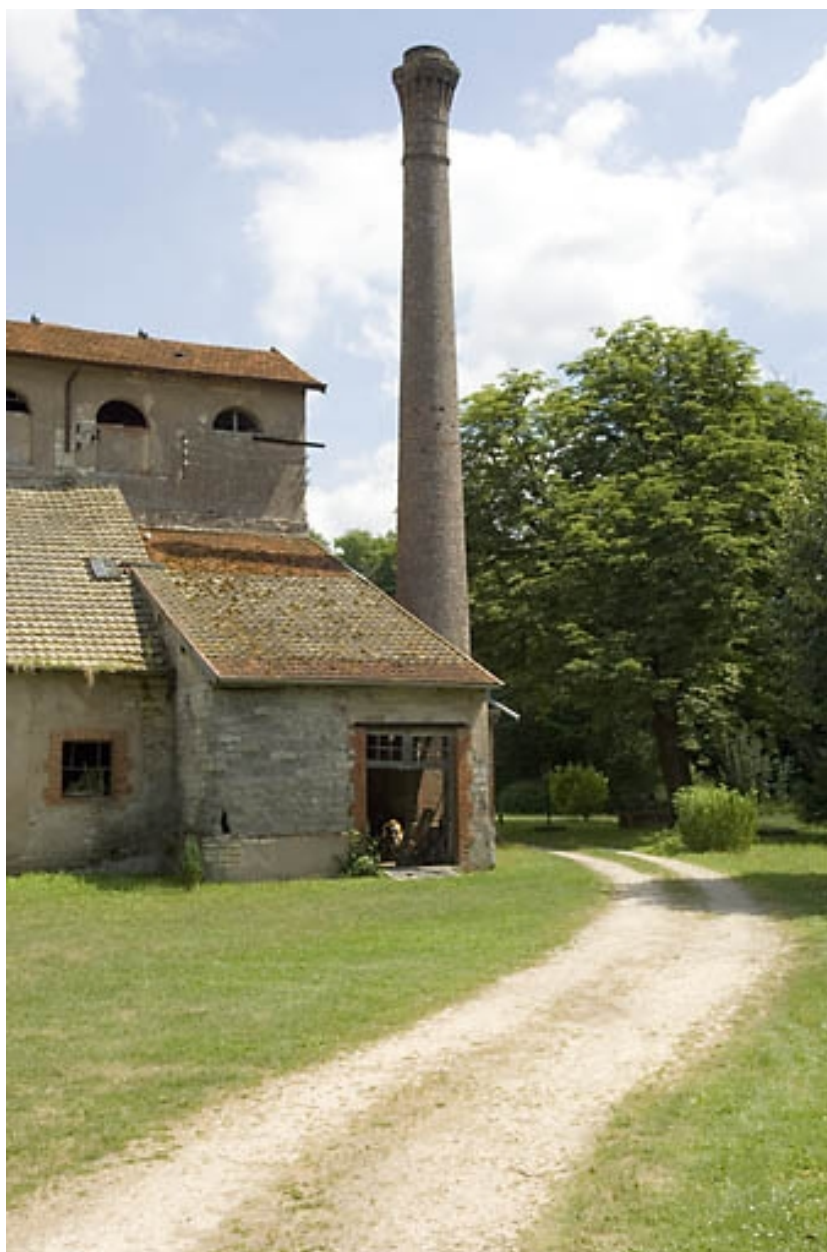
Chaufferie et cheminée au sud du haut fourneau.
