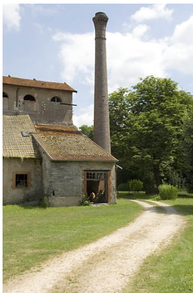
Chaufferie et cheminée au sud du haut fourneau. Phot. Jérôme Mongreville IVR43_20087000684NUC2A
