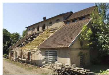
Le haut fourneau vu de trois quarts. Phot. Jérôme Mongreville IVR43_20087000675NUC2A
