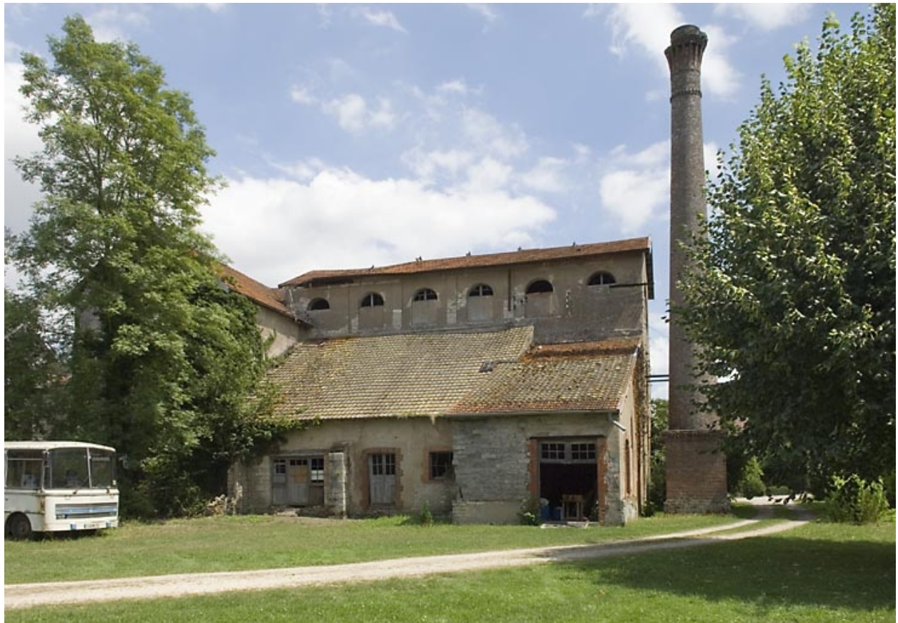
Elévation ouest du haut fourneau.
