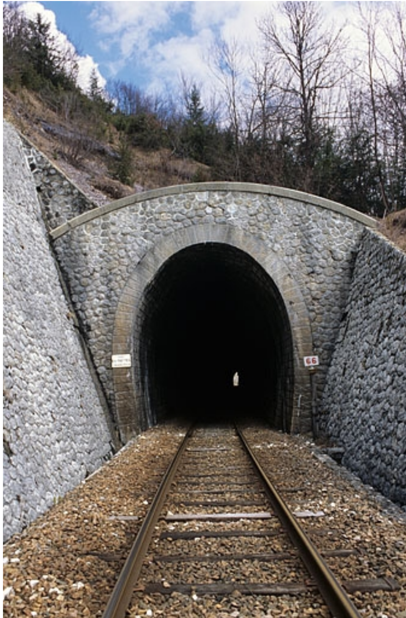
Tunnel des Frettes : tête côté La Cluse (sud).
