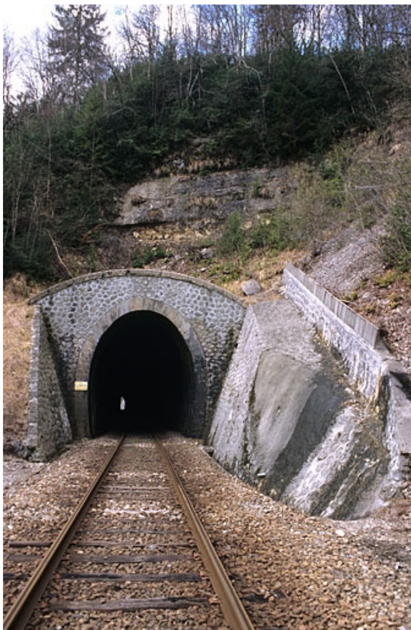
Tunnel des Frettes : tête côté Andelot-en-Montagne (nord).
