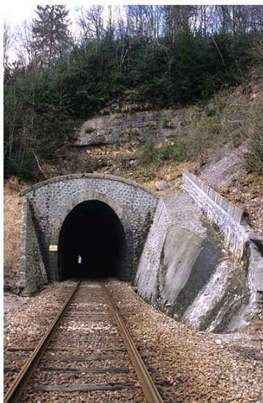
Tunnel des Frettes : tête côté Andelot-en-Montagne (nord). Phot. Yves Sancey IVR43_20053900687ZA
