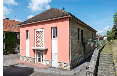
Le mur pignon sud. Phot. Jérôme Mongreville IVR43_20177000730NUC4A
