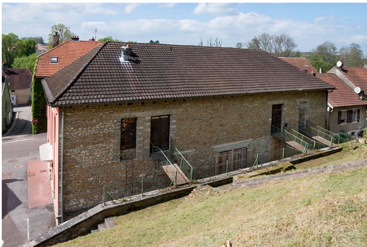
La façade postérieure.
