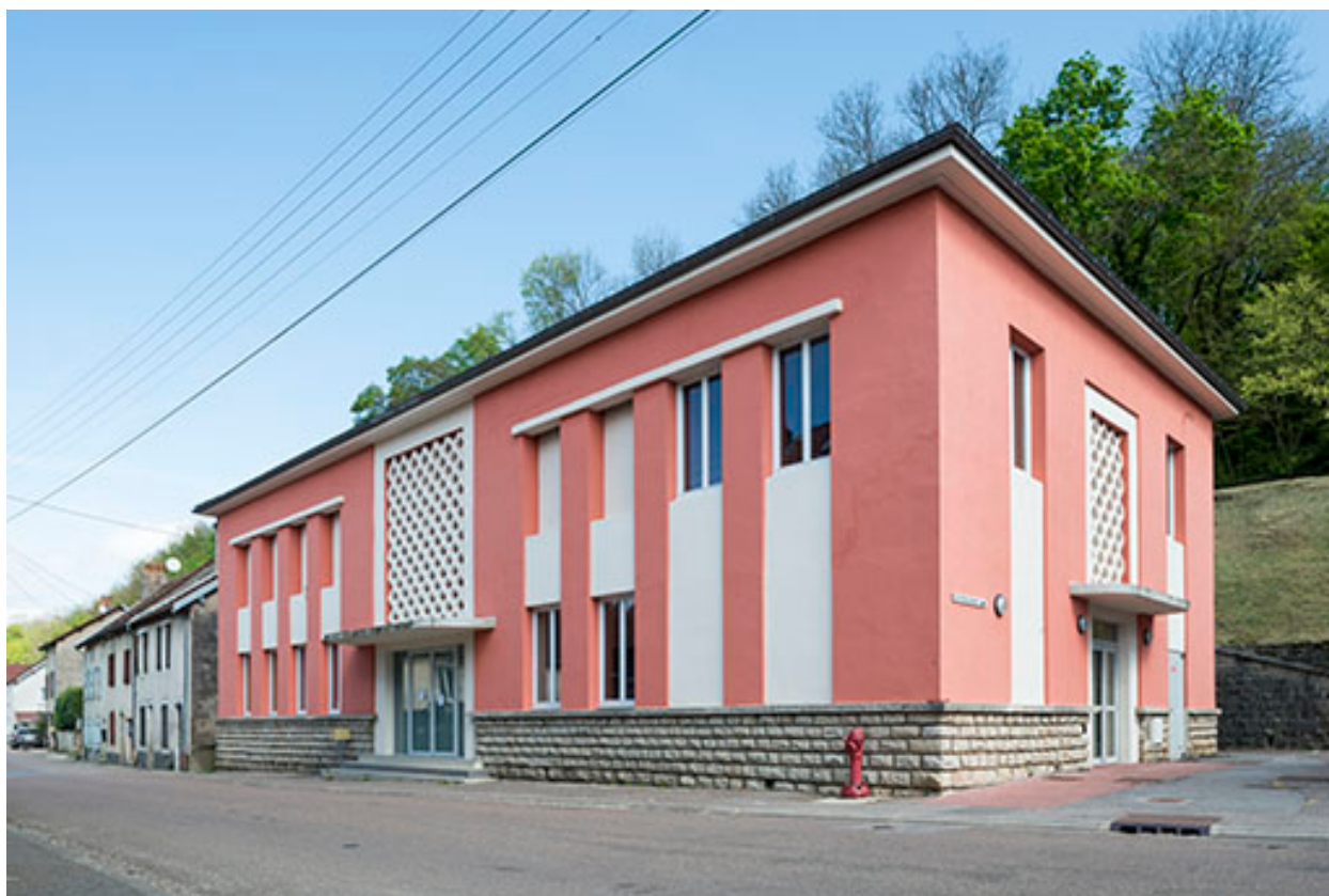
Vue générale de l'édifice.
