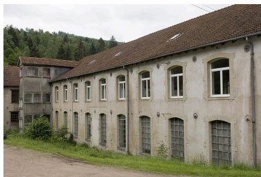
Façade est de la réception et de l'atelier de rentrage. Phot. Jérôme Mongreville IVR43_20067000456NUCA
