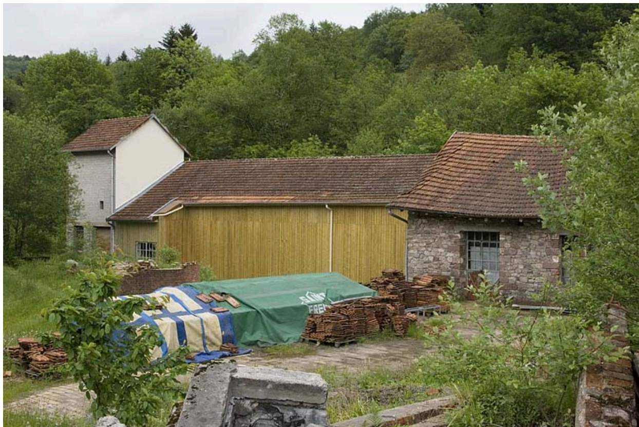
Transformateur, salle des machines, bâtiment d'eau et atelier de réparation.
