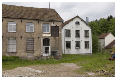
Extrémité sud de la réception et pignon d'un atelier de tissage. Phot. Jérôme Mongreville IVR43_20067000448NUCA
