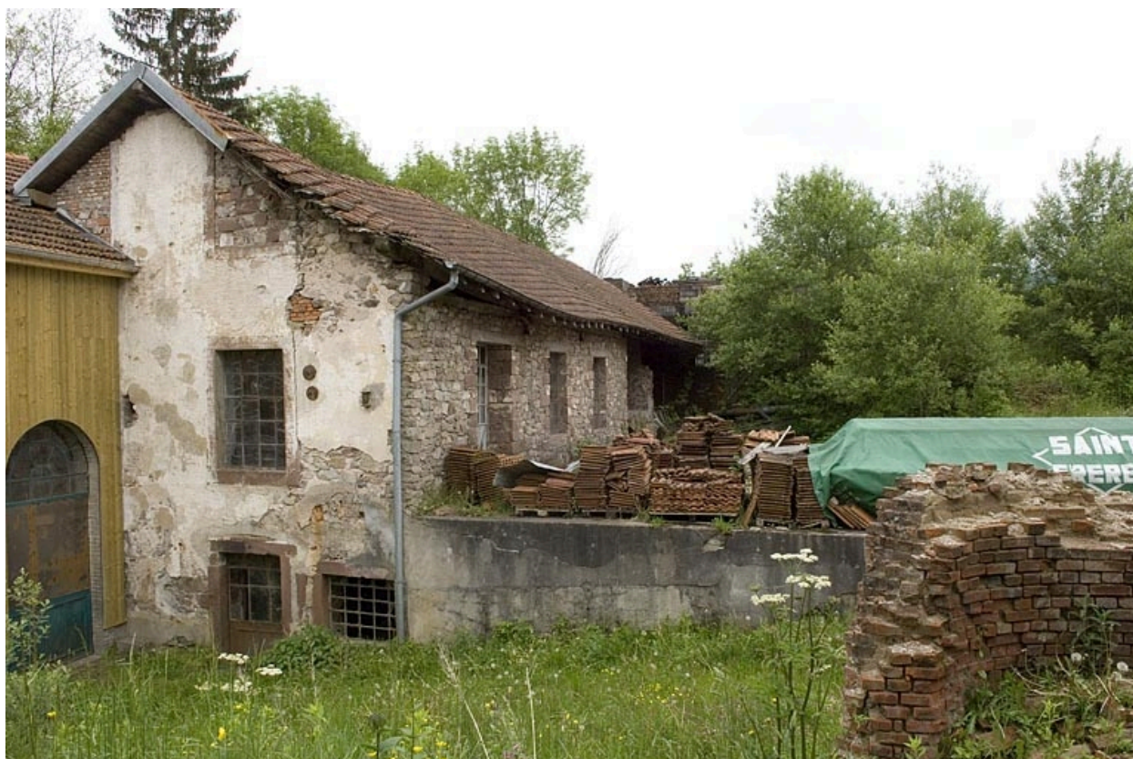
Atelier de réparation (forge et menuiserie).
