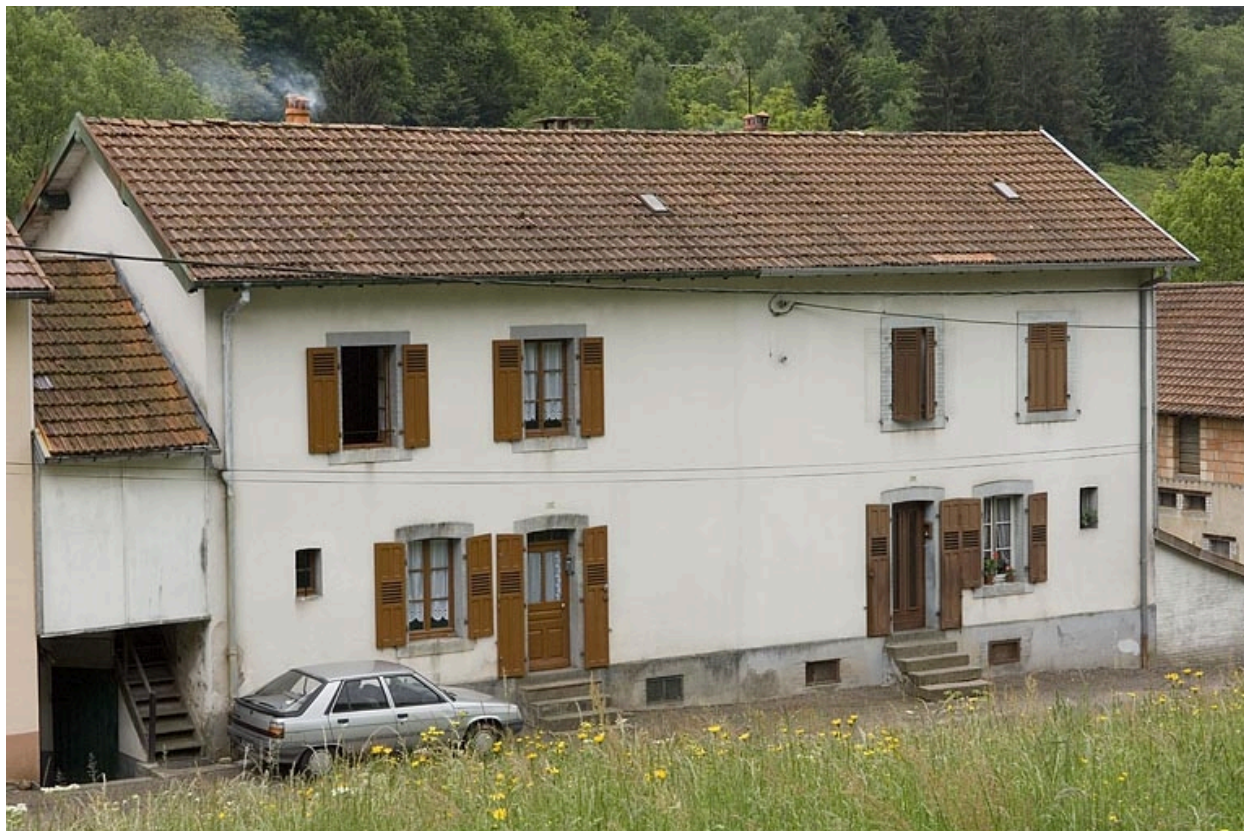
Logement ouvrier collectif (rue de l'Usine).
