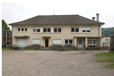
Immeuble de bureaux. Phot. Jérôme Mongreville IVR43_20067000450NUCA
