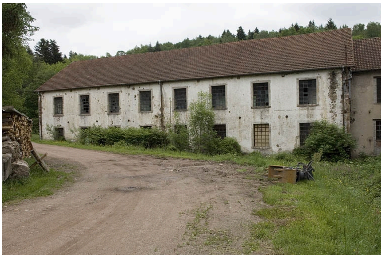
Façade nord-ouest de l'atelier de tissage.
