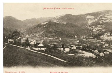
Haut-du-Them (Haute-Saône). Entrée du village. Phot. , Autr. Thomas IVR43_200670000184NUCA
