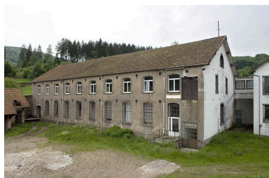
Réception et atelier de renrage. Phot. Jérôme Mongreville IVR43_20067000452NUCA
