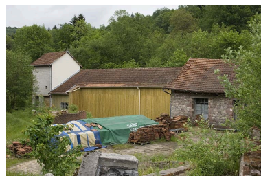
Transformateur, salle des machines, bâtiment d'eau et atelier de réparation. Phot. Jérôme Mongreville IVR43_20067000451NUCA
