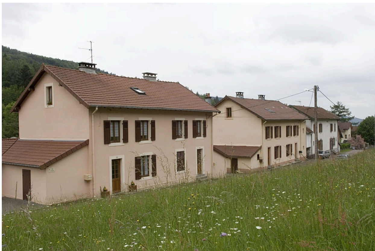
Cité ouvrière (rue de l'Usine).
