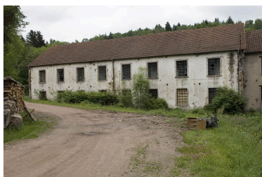
Façade nord-ouest de l'atelier de tissage. Phot. Jérôme Mongreville IVR43_20067000457NUCA
