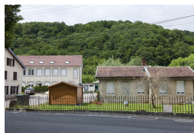
Atelier et bureau (?). Phot. Jérôme Mongreville IVR43_20122501053NUC4A
