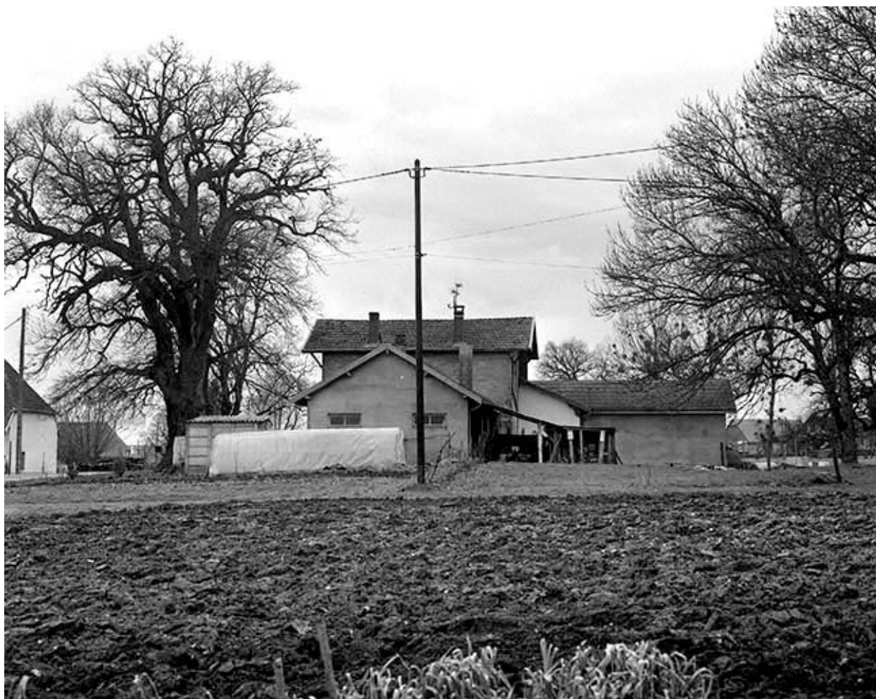
Façades latérales nord.
