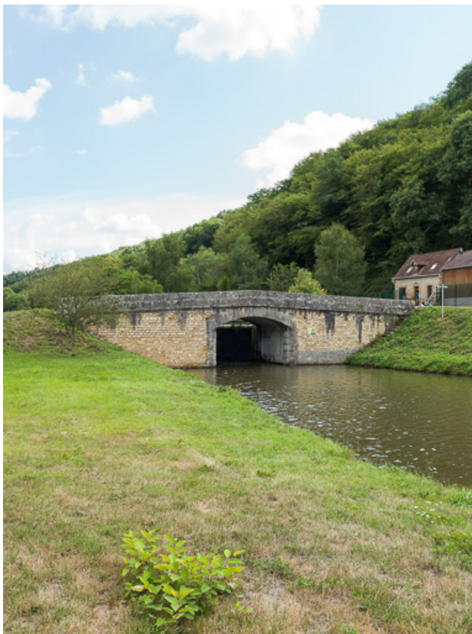
Vue d'ensemble du pont.
