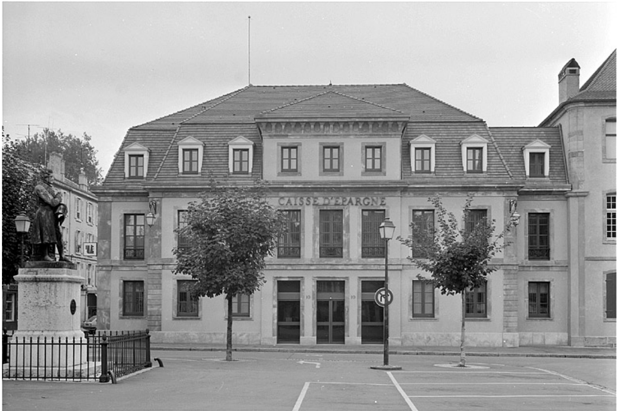
Façade nord après reconstruction.
