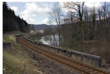
Vue d'ensemble, depuis le côté Andelot-en-Montagne. Phot. Yves Sancey IVR43_20073900142NUCA
