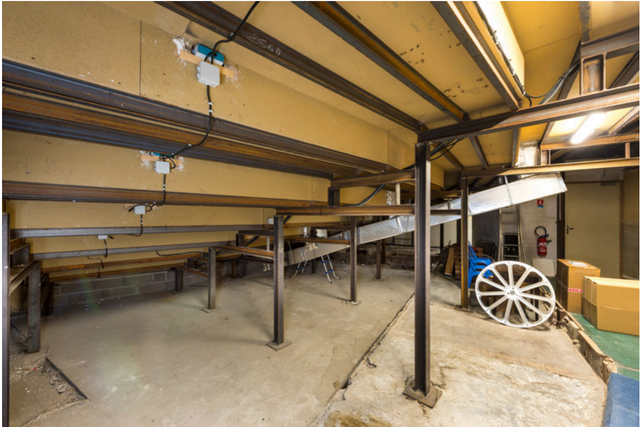
Espace sous les gradins de la salle.
