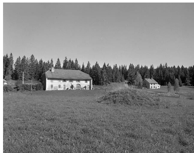
Façade antérieure, vue éloignée. Phot. Jérôme Mongreville IVR43_20003900474X
