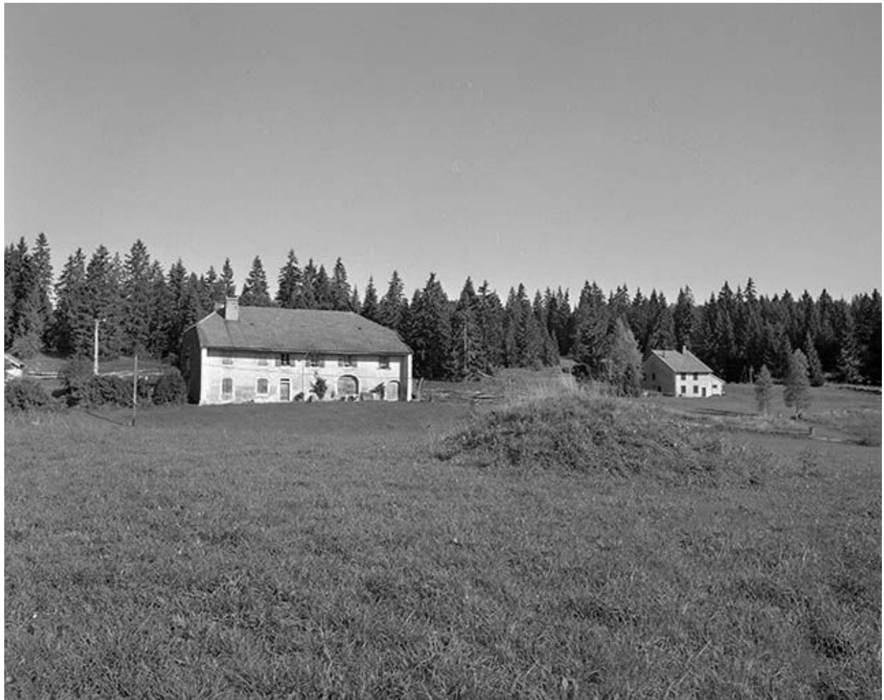
Façade antérieure, vue éloignée.
