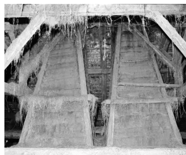
Conduits des "tués"jumelés dans la grange, de face. Phot. Yves Sancey IVR43_19772500428X
