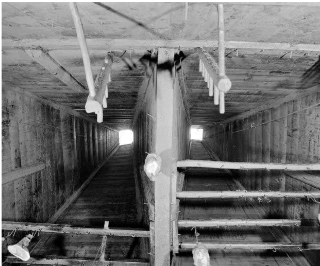
Intérieur : conduit des "tués"jumelés.
