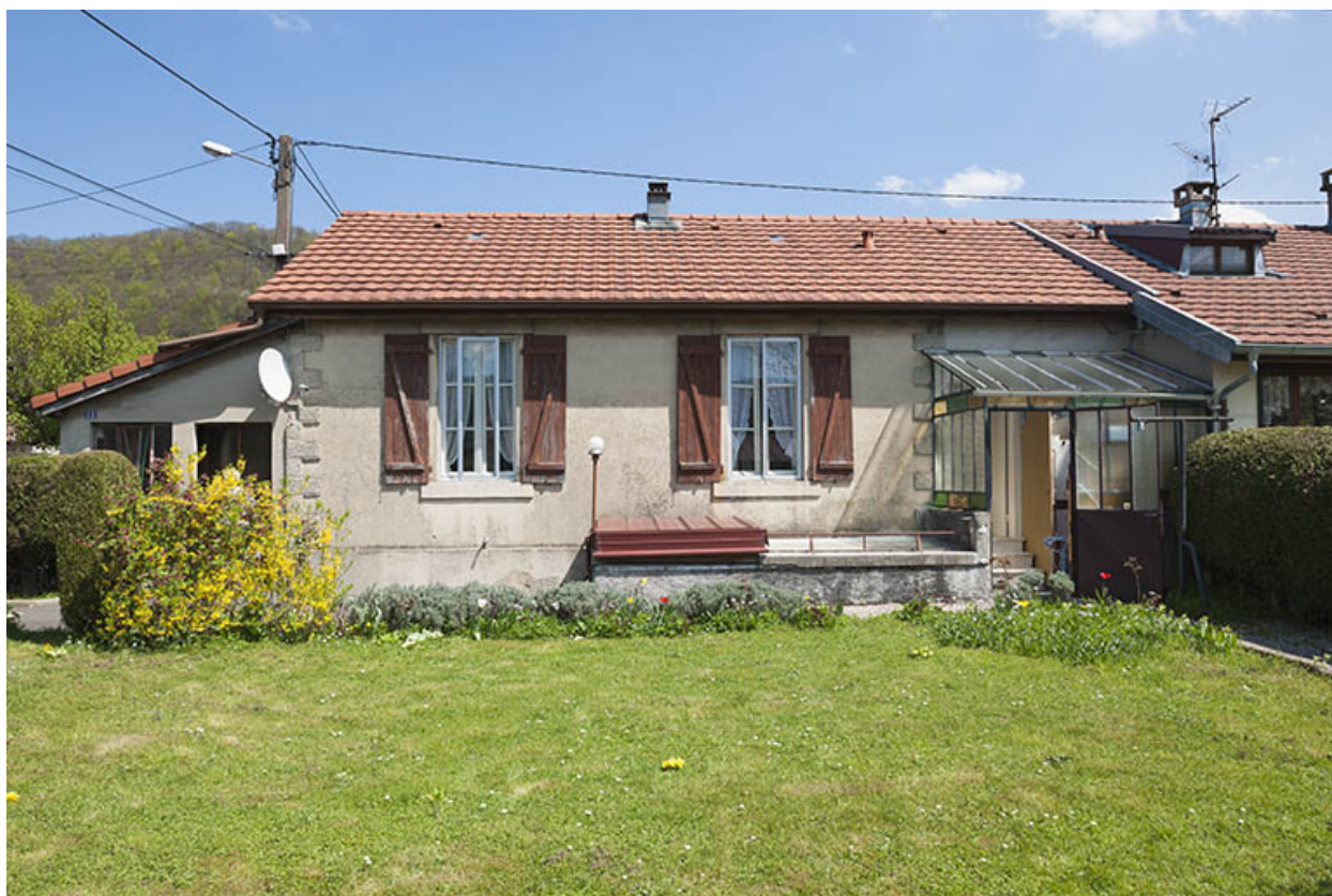
Façade postérieure d'une maison individuelle.
