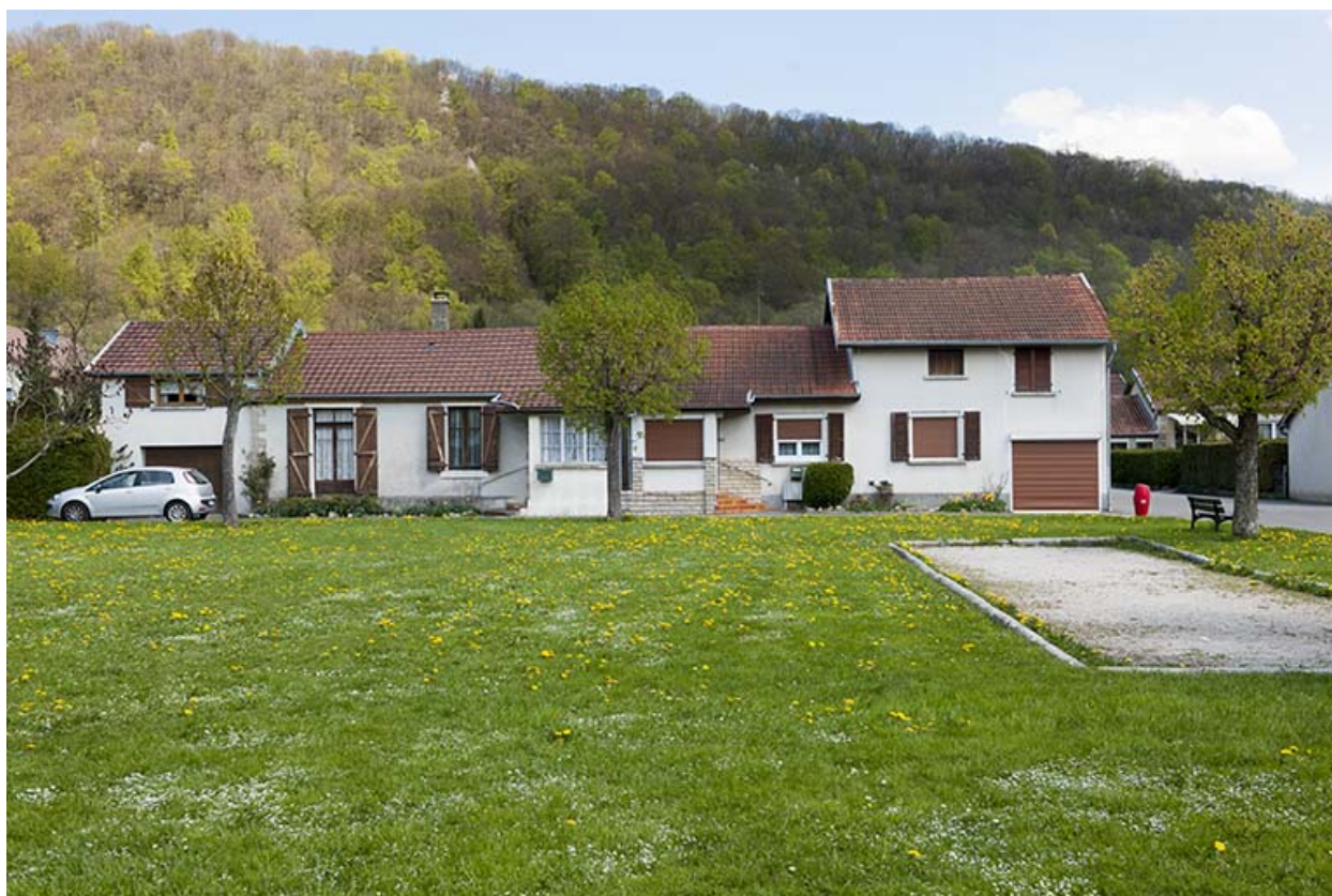
Maisons ouvrières donnant sur la place.
